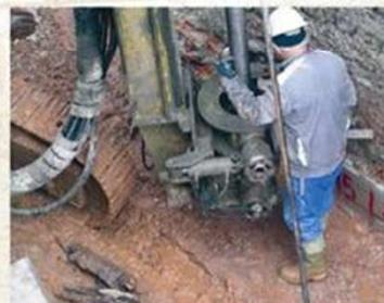
LAVORI DI CONSOLIDAMENTO DELLE FONDAZIONI, TECNICA DEL "JET GROUTING"
