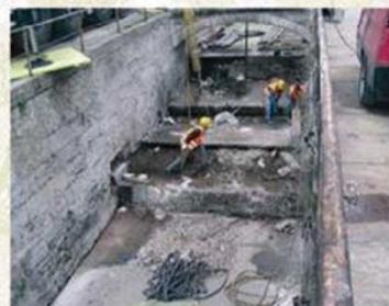
LAVORI DI DEMOLIZIONE DEL FONDO DEL CANALE SCARICATORE
