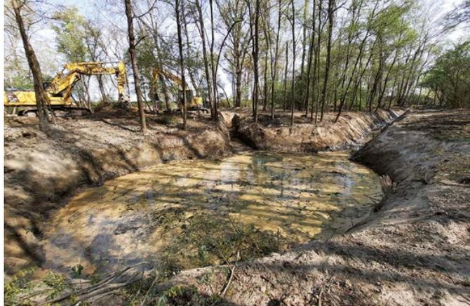
Lotto 3 - Intervento 7 - potenziamento e riconnessione della risorgiva del bosco Tetti Girone, riprofilatura delle pozze delle risorgive e dei canali di connessione al Pellice.
