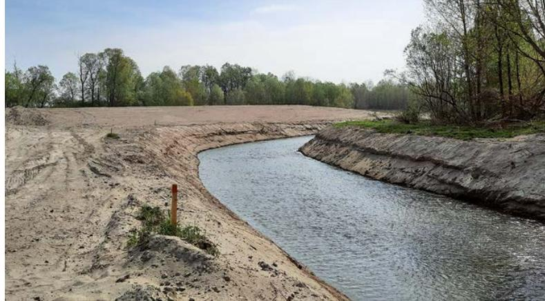
Lotto 5 - Intervento 9 - apertura del nuovo ramo in destra idraulica e realizzazione dell'abbancamento a protezione della sponda sinistra - fase di cantiere vista da monte.
