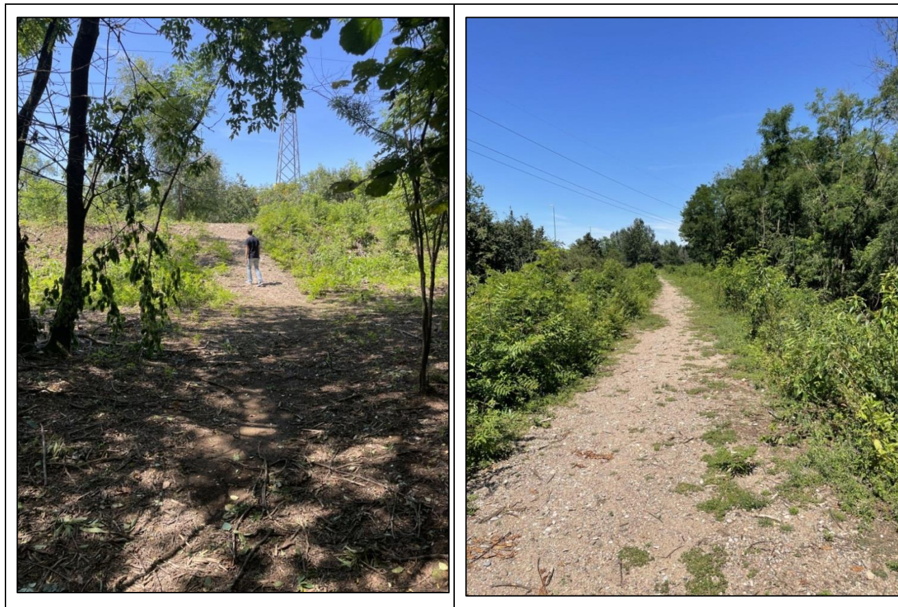
FIGURA 9-3 RAMPA E SOMMITÀ ARGINALE CHE VERRANNO INTERESSATI DAL RINGROSSO IN SAGOMA E IN QUOTA E SU CUI È STATO ESEGUITO IL TAGLIO SELETTIVO DEGLI ARBUSTI
