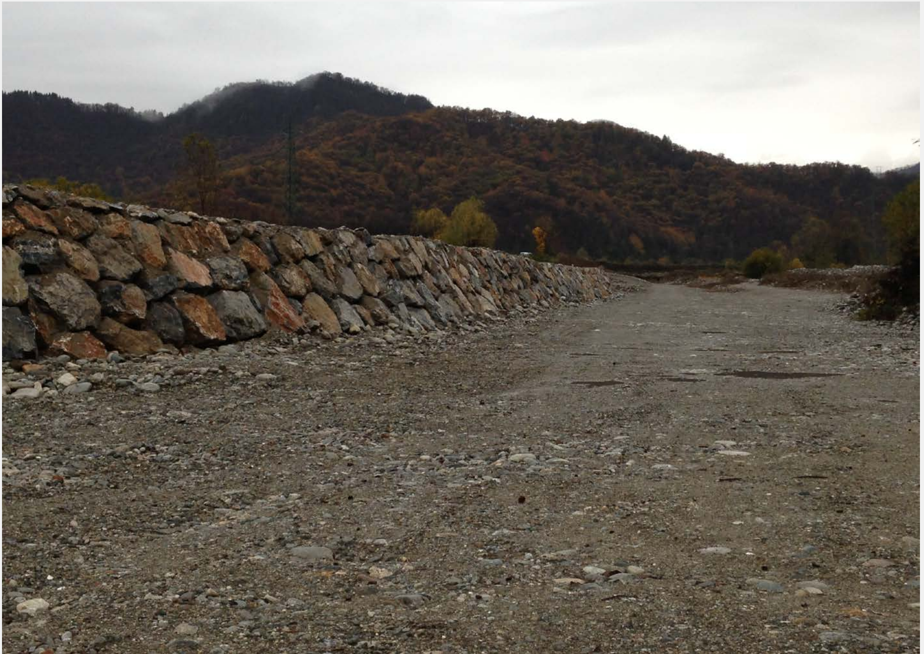
Realizzazione della scogliera in massi ciclopici non cementati lungo la sponda destra del torrente Gesso
