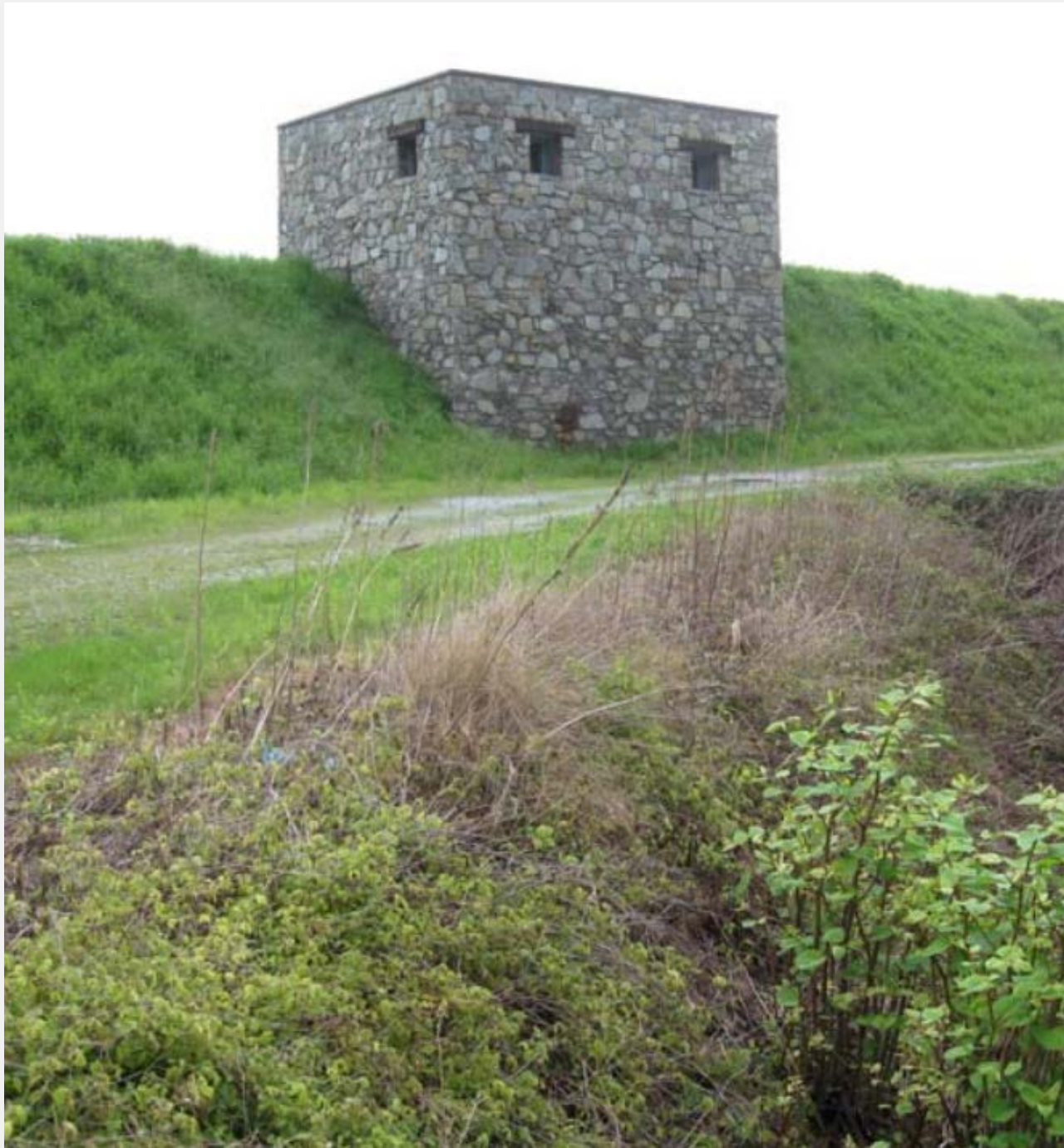
Lessolo (TO), Fiume Dora Baltea , Stazione di pompaggio
