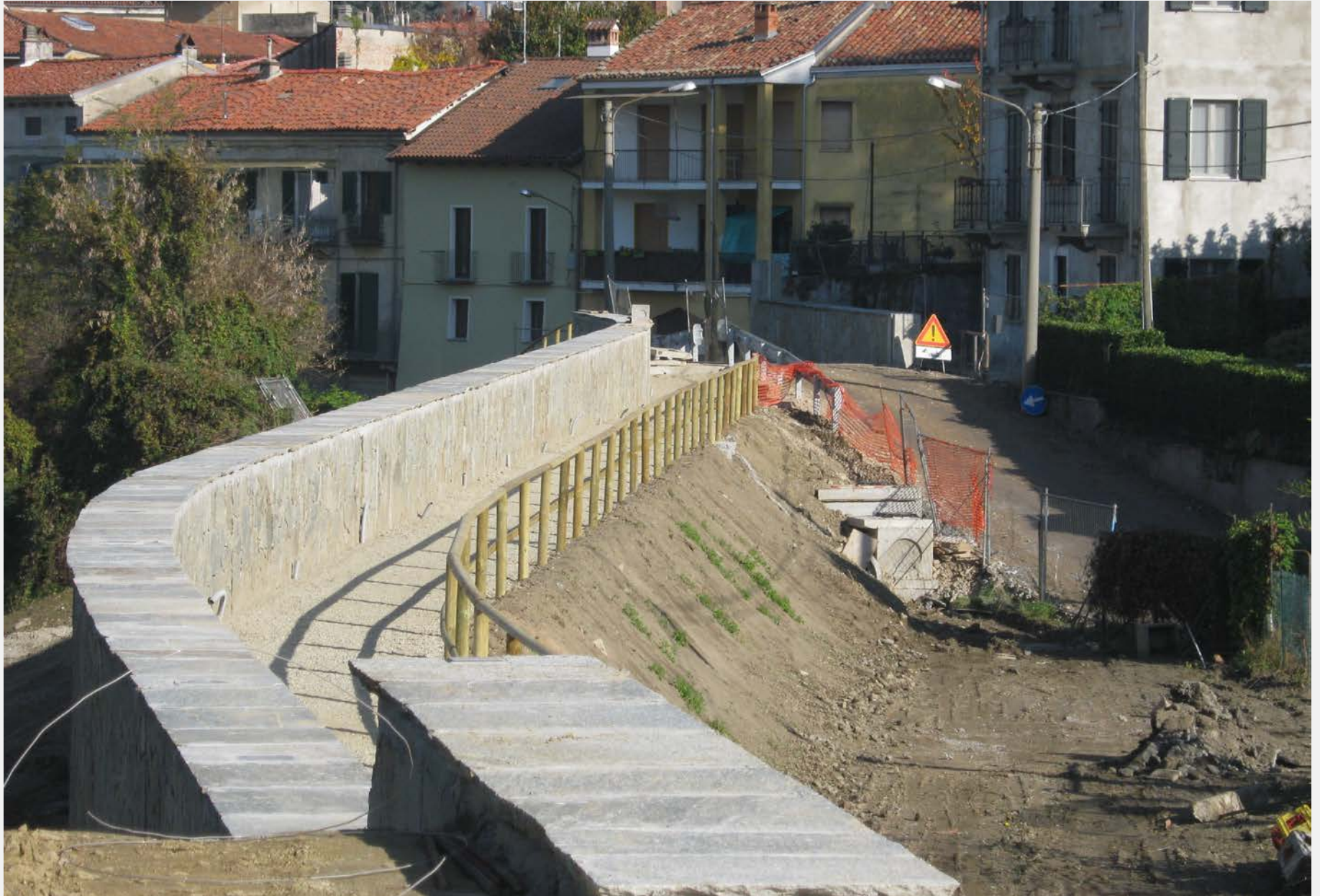
Realizzazione muro arginale in c.a. rivestito con pannellature prefabbricate lungo la sponda destra del Fiume Dora Baltea in comune di Ivrea (Via delle Rocchette)
