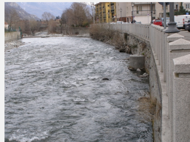
Vista verso valle dal ponte cittadino
