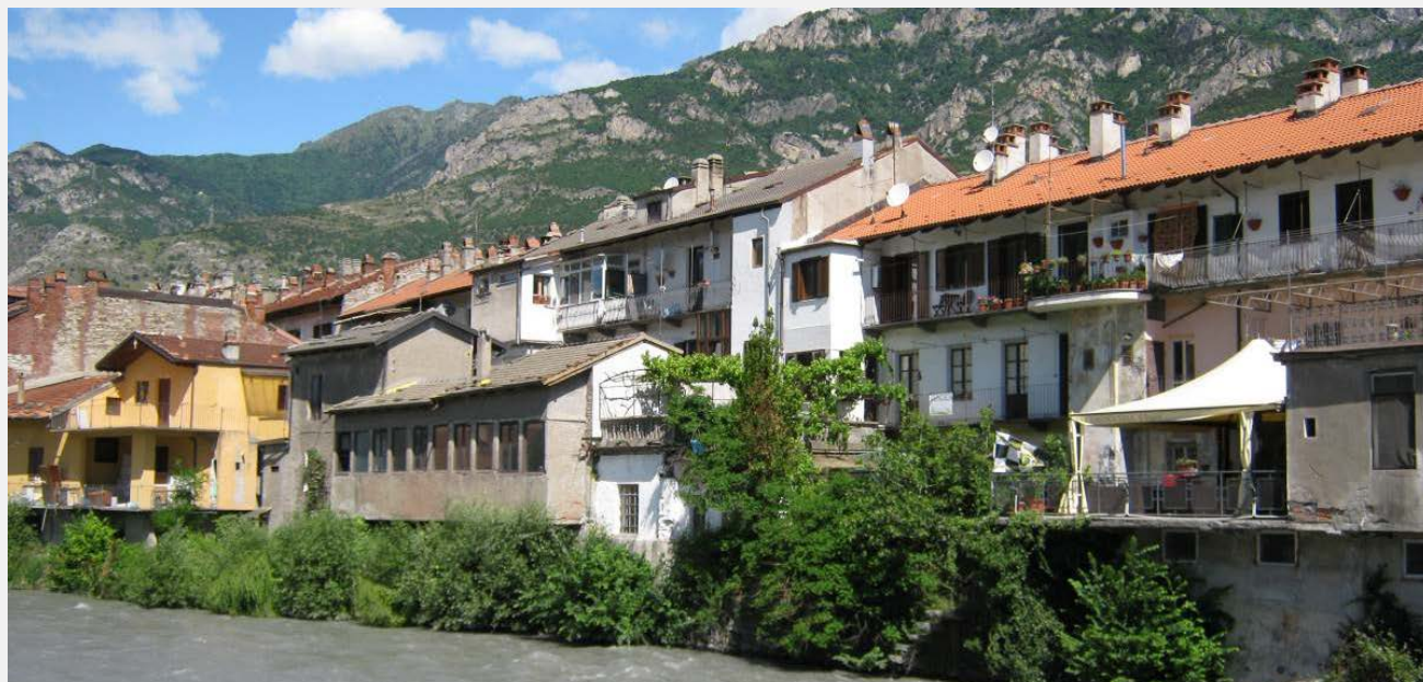
Vista del tratto cittadino a monte del “Ponte Vecchio”
