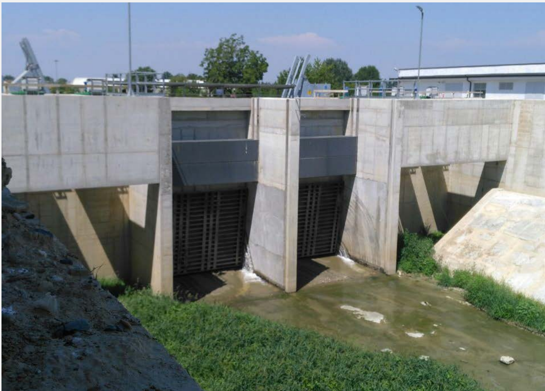
Impianto della chiavica del Rio Loreto visto da valle
