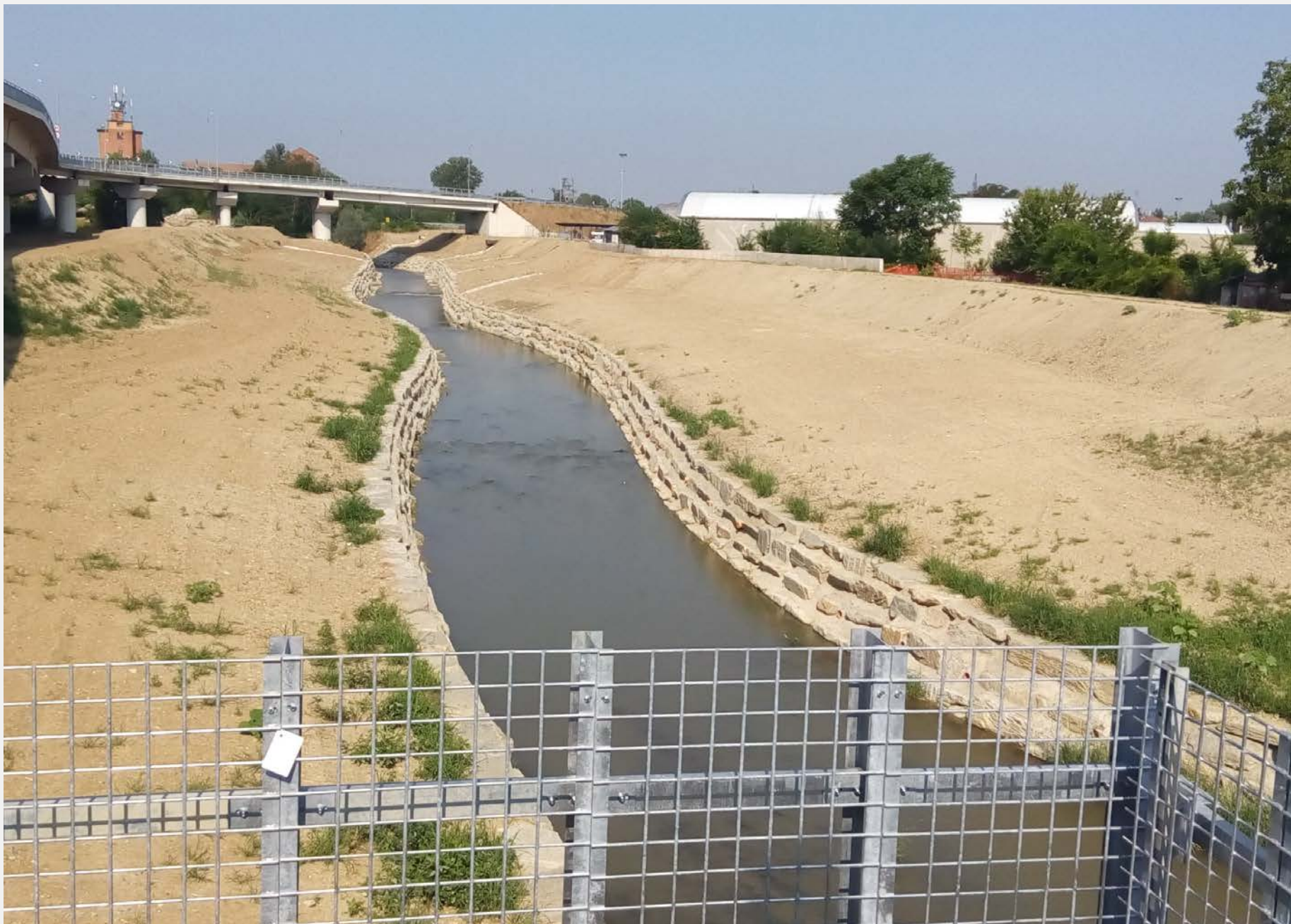
Realizzazione argini di rigurgito su entrambe le sponde del Rio Loreto
