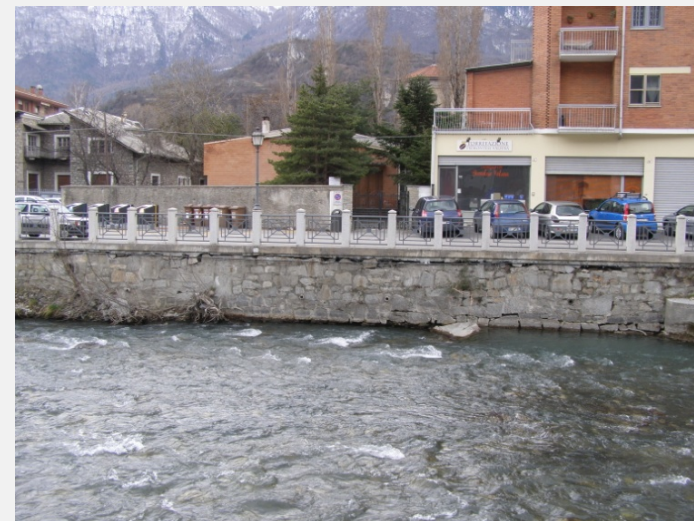
Vista frontale dei muretti esistenti
