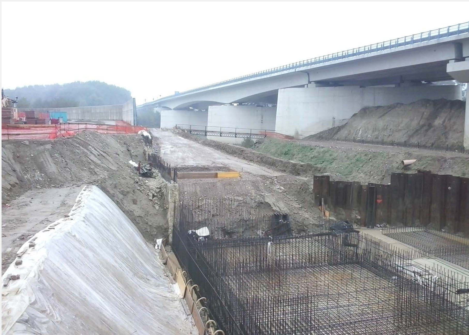
Realizzazione delle armature della platea di fondazione della chiavica
