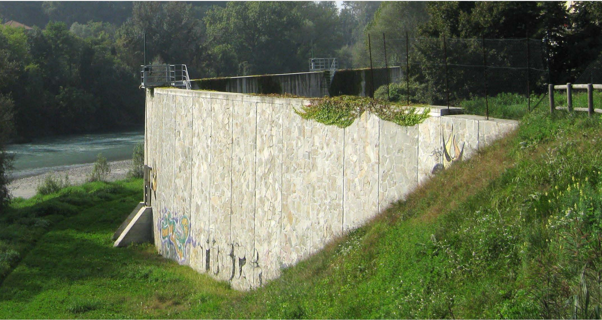
Ivrea (TO), Fiume Dora Baltea , Muro arginale via Aldisio
