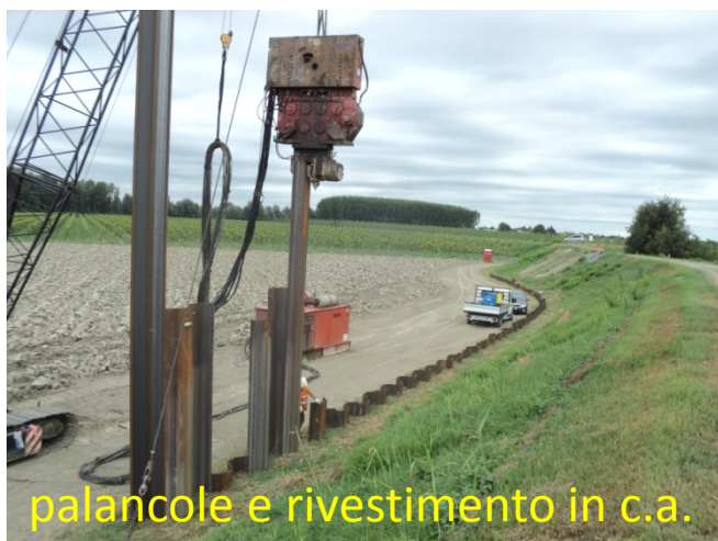
Cavezzo, Via Bozzala
