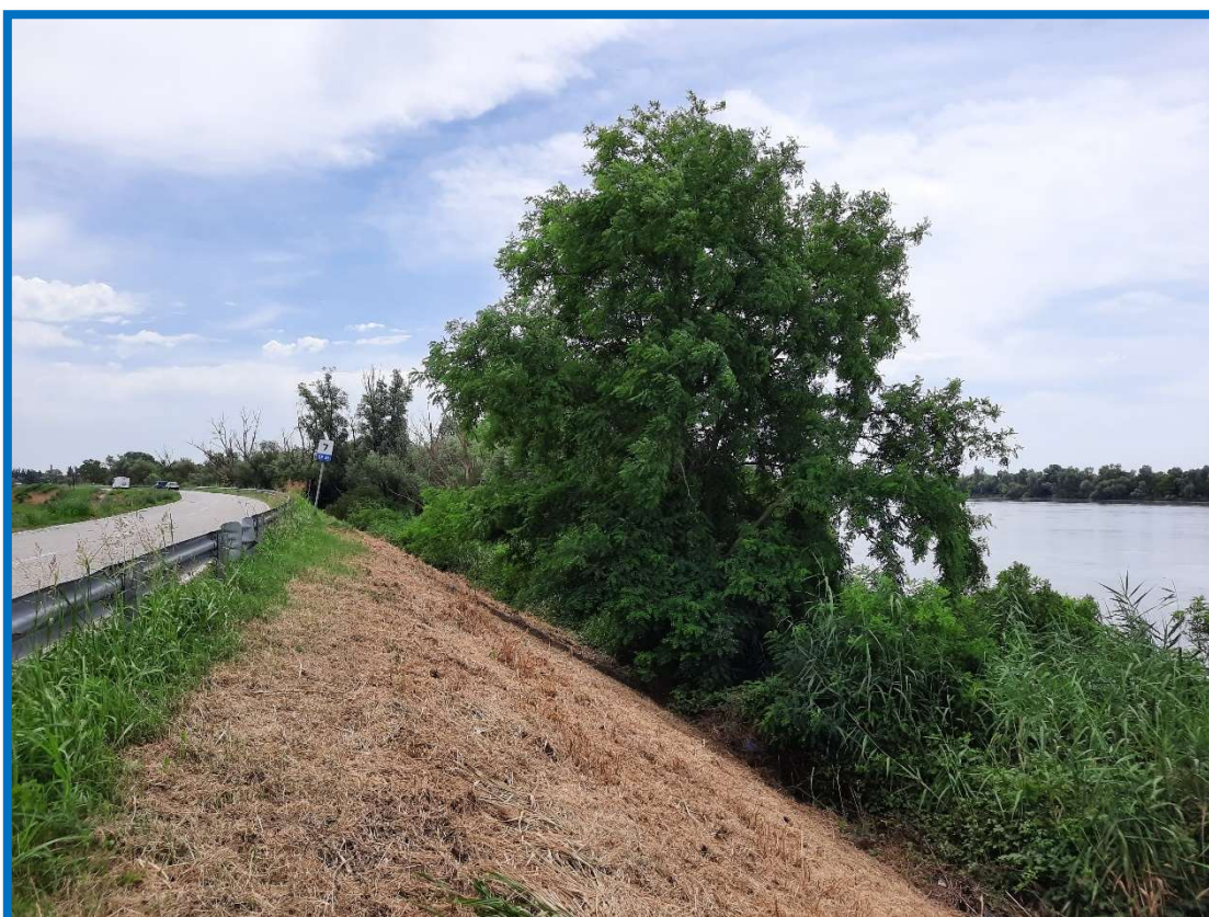
Foto 4 – T.C. 5 - Sinistra Po – stante 542 – Alberi e cespugli sul rilevato arginale in "frollo"
