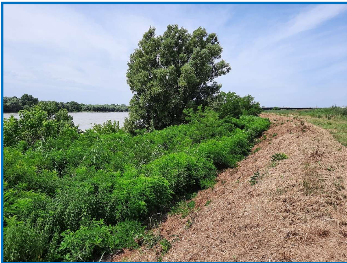
Foto 3 – T.C. 5 - Sinistra Po – stante 504 – Folta vegetazione cespugliosa sul rilevato arginale
