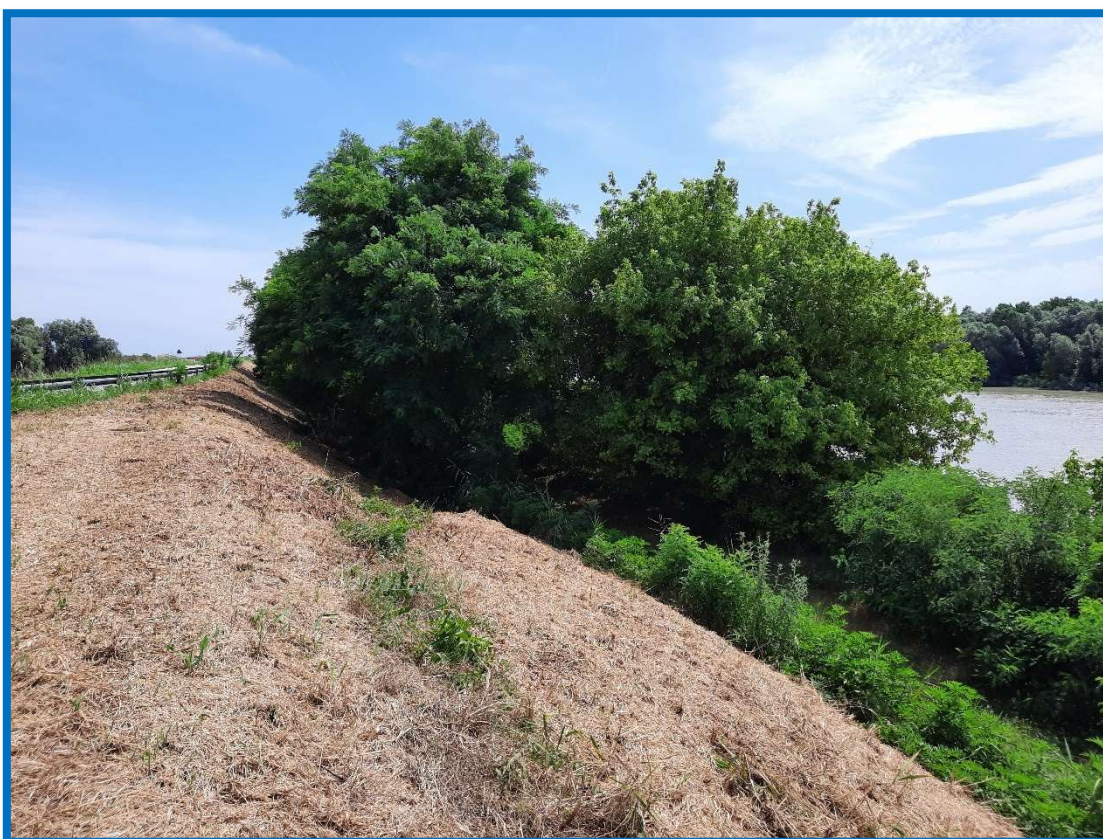
Foto 2 – T.C. 5 - Sinistra Po – Stante 491 – Vegetazione cespugliosa e alberi sul corpo arginale
