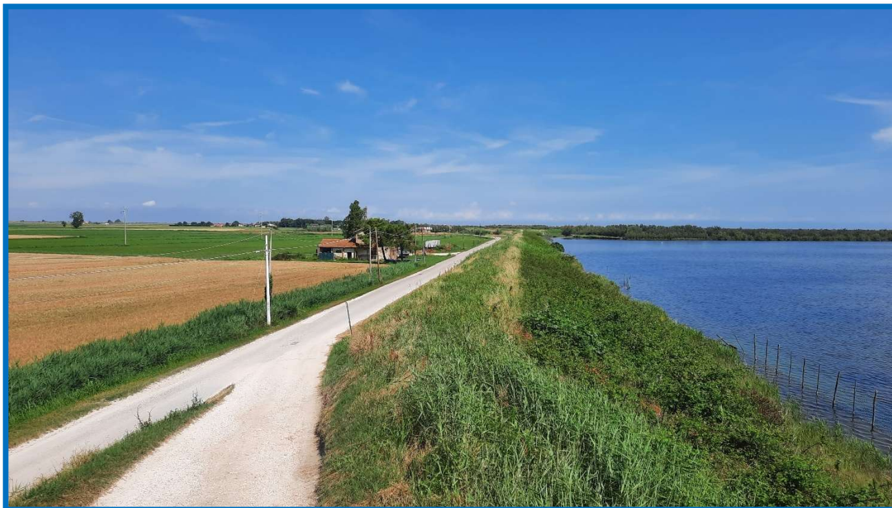
Foto 11 – T.C. 14 - 2^ difesa a mare – Stante 9 – Sommità arginale non percorribile a causa delle ridotte dimensioni
