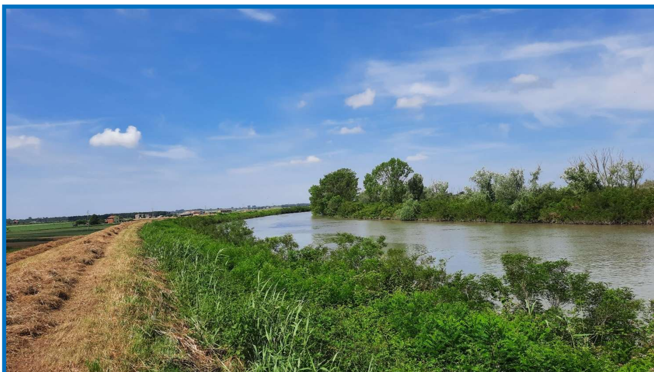
Foto 14 – T.C. 14 – Destra Po di Maistra - Stante37 – Vegetazione cespugliosa sul rilevato arginale in “faldo”
