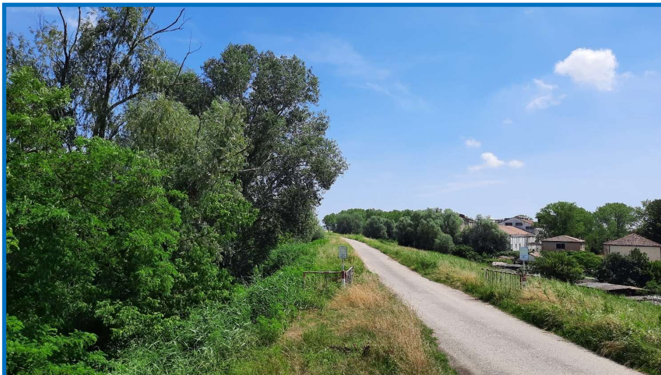
Foto 13 – T.C. 14 – Destra Po di Maistra – Stante 2 – Alberi presenti in scarpata e al piede arginale
