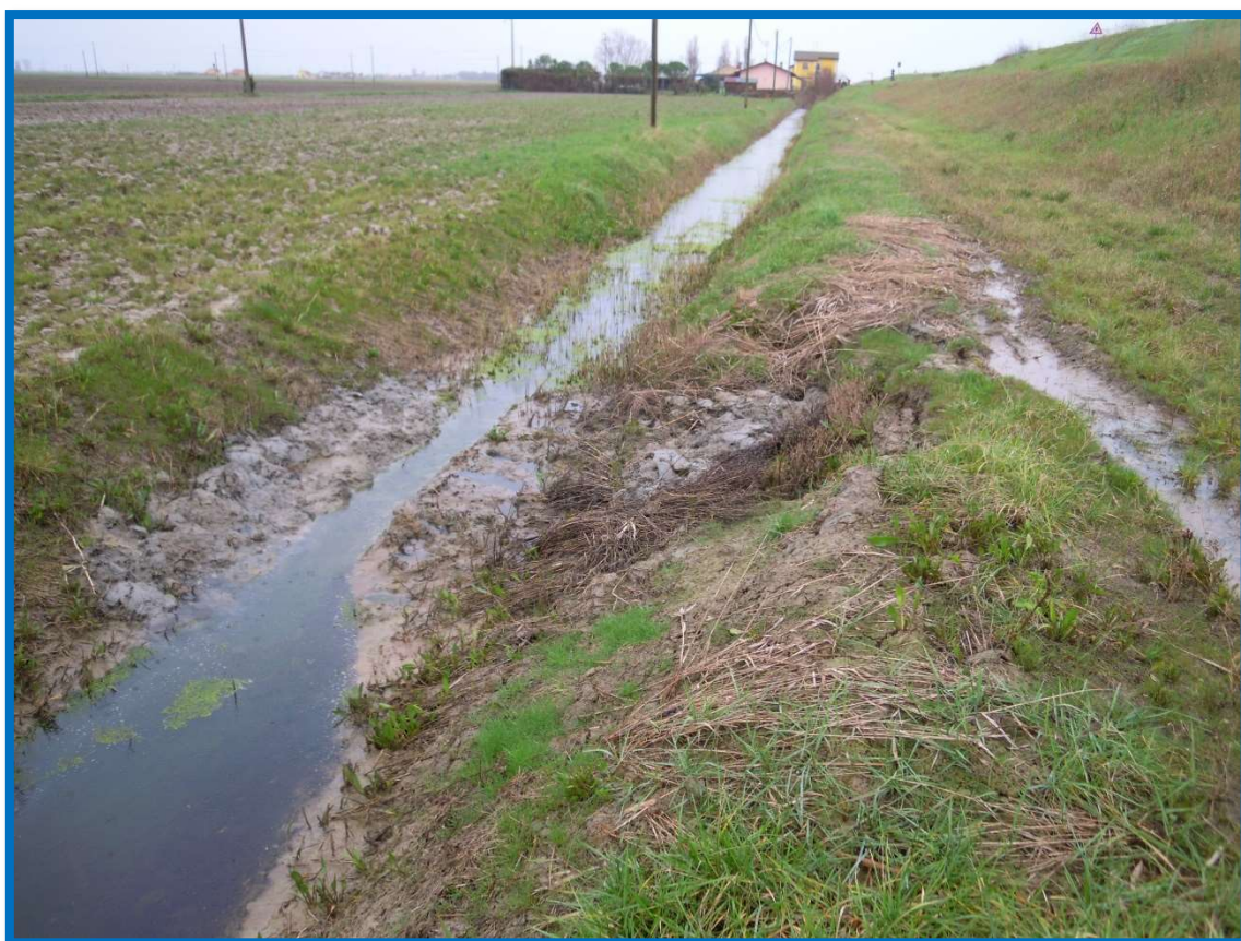
Foto 12 – T.C. 14 - 2^ difesa a mare – Stante 15 – Franamento del rilevato arginale a campagna
