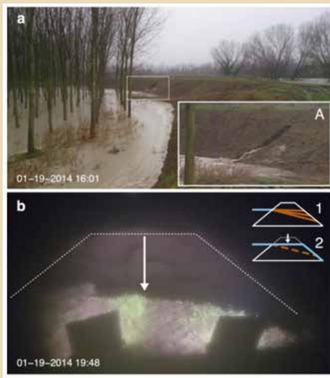
Figura 1. Documentazione fotografica del collasso di un'arginatura dovuto alla presenza di una tana d'istrice.
