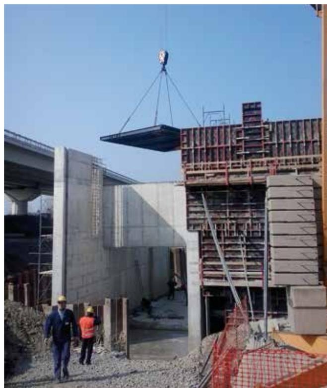
Figura 18 - fase di posizionamento delle paratoie a libro
