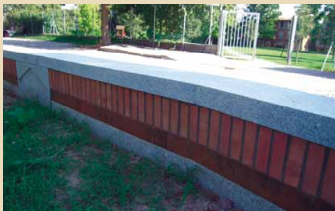
foto 3 – Fiume Adda a Lodi: muro di sponda destra a valle del ponte cittadino
