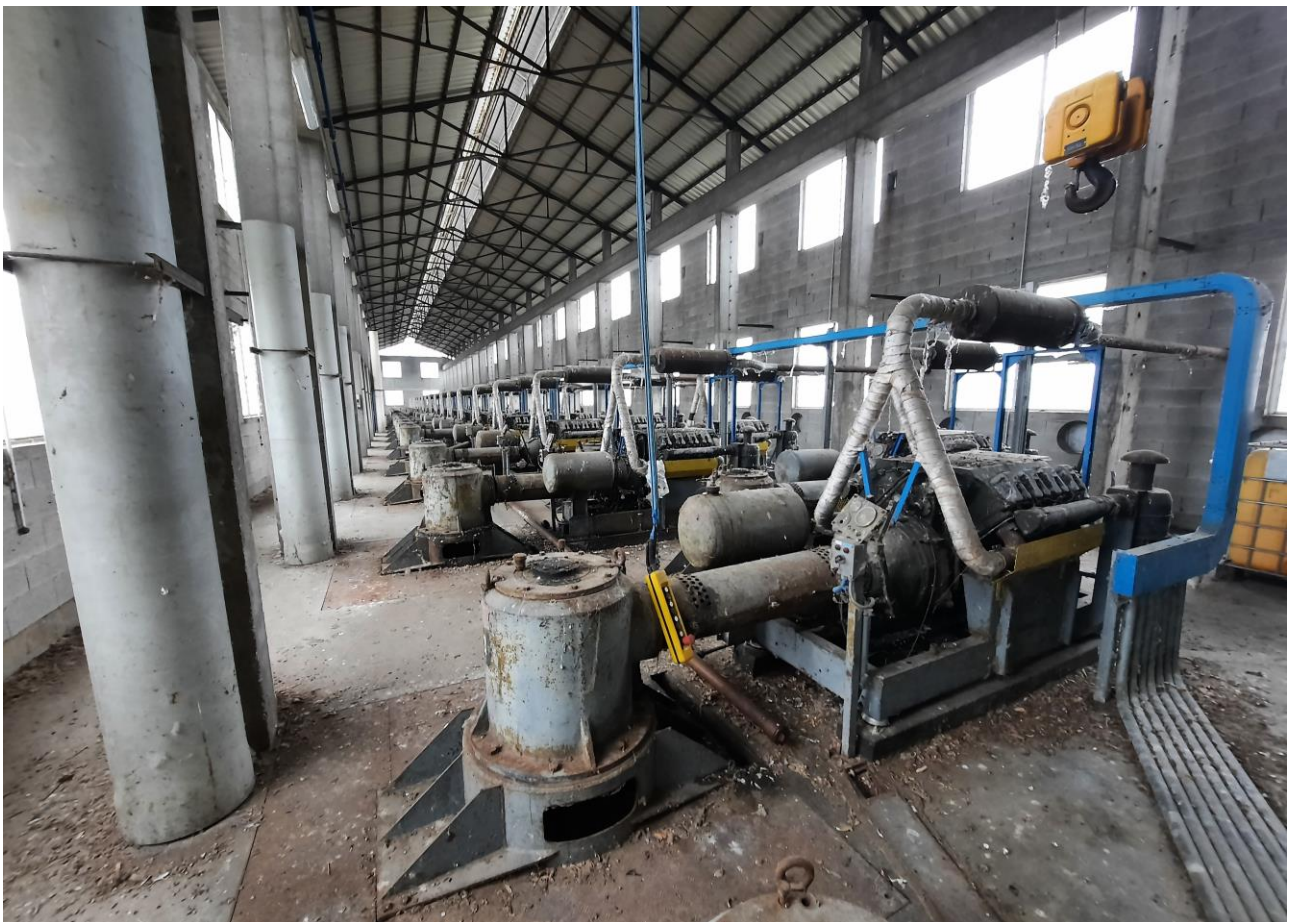
Figura 2 – Piano rialzato locale interno fabbricato e motori endotermici diesel.
