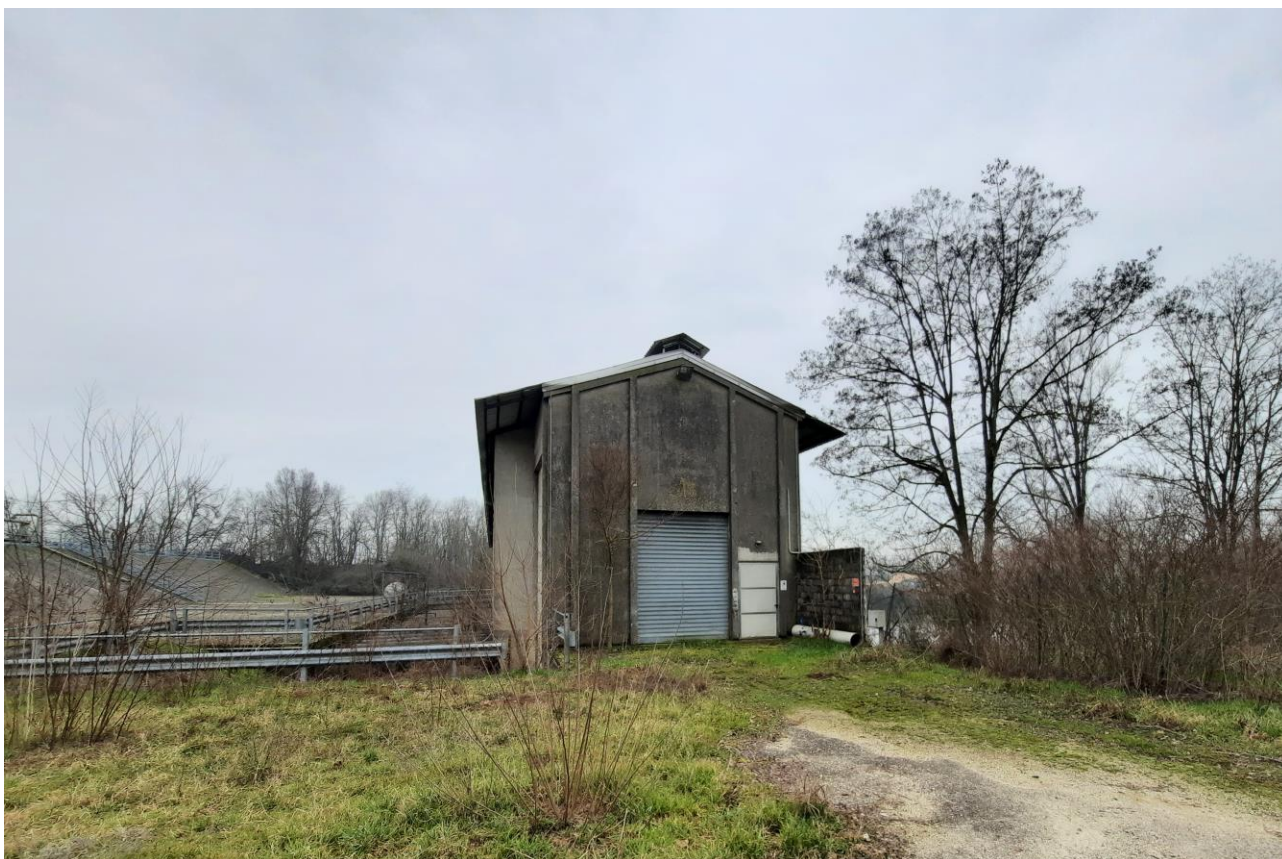
Figura 4 – Vista lato Nord – Accesso al fabbricato, porta a saracinesca ammalorata e fuori uso.
