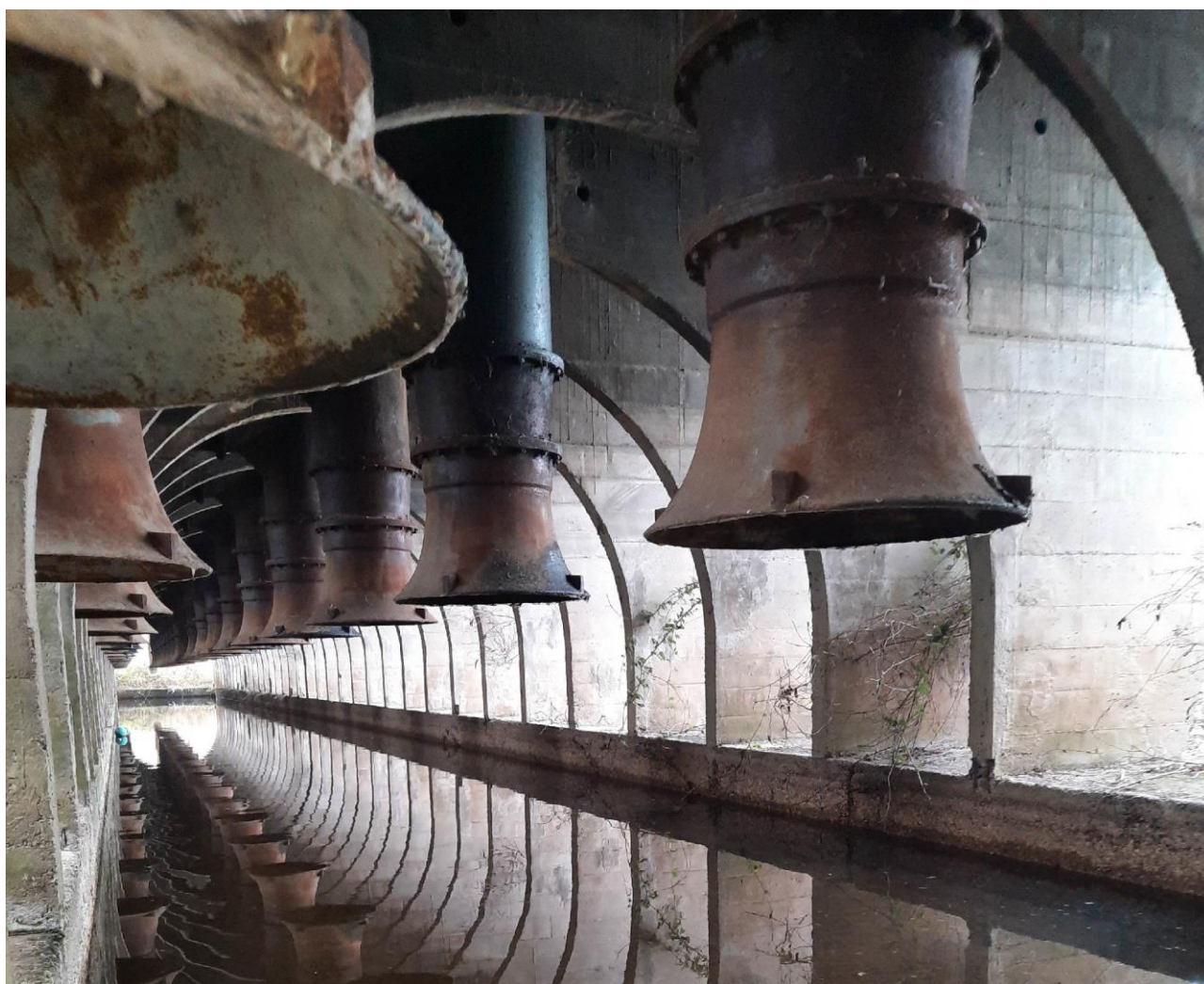
Figura 5 – Camera di raccolta dell’acqua invasata dei laghi di Mantova e campane di aspirazione.
