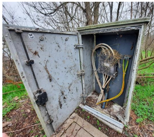
Figura 10 – Carroponte esistente e quadri elettrici danneggiati dalle intemperie.
