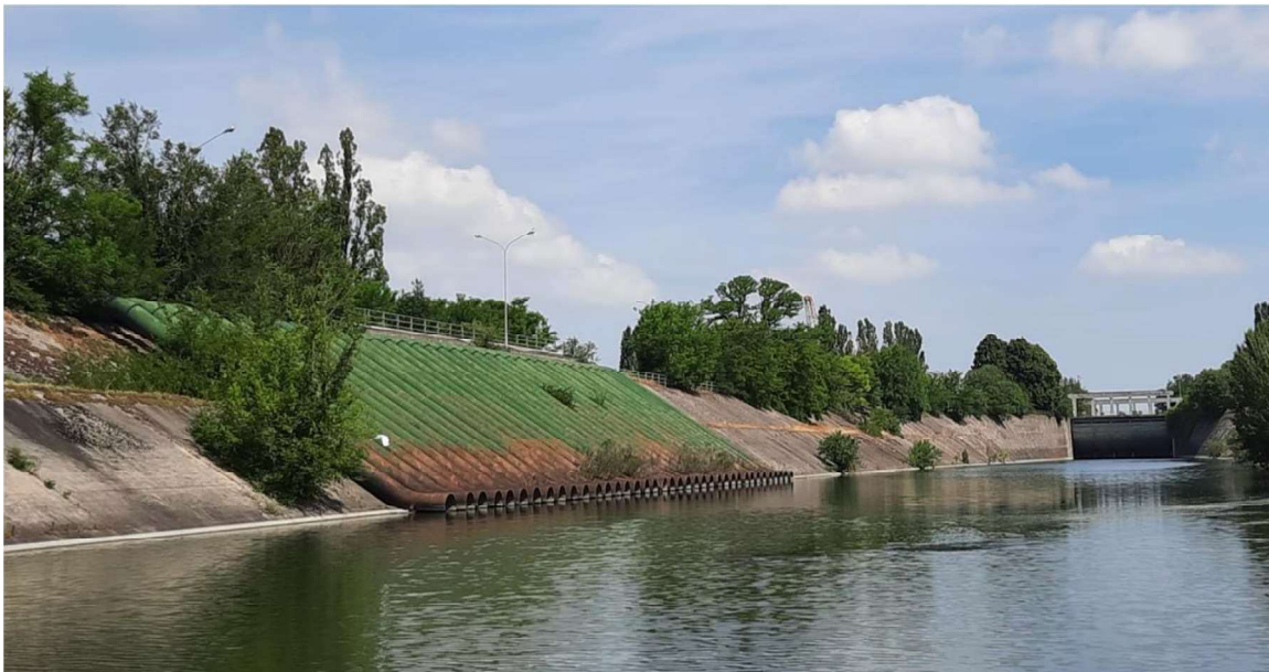
Figura 2-3. Tubazioni in uscita dall'impianto di sollevamento di Valdaro che scaricano nel canale Diversivo.
