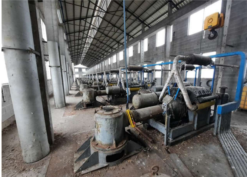
Figura 2-2. Piano rialzato della struttura di alloggiamento dell'impianto di sollevamento.
