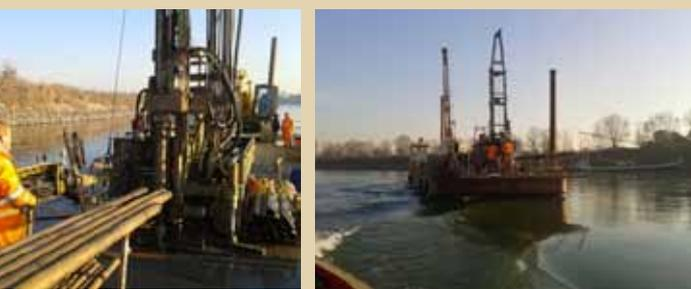
Fig. 2 - Esecuzione di sondaggio a carotaggio continuo in alveo
