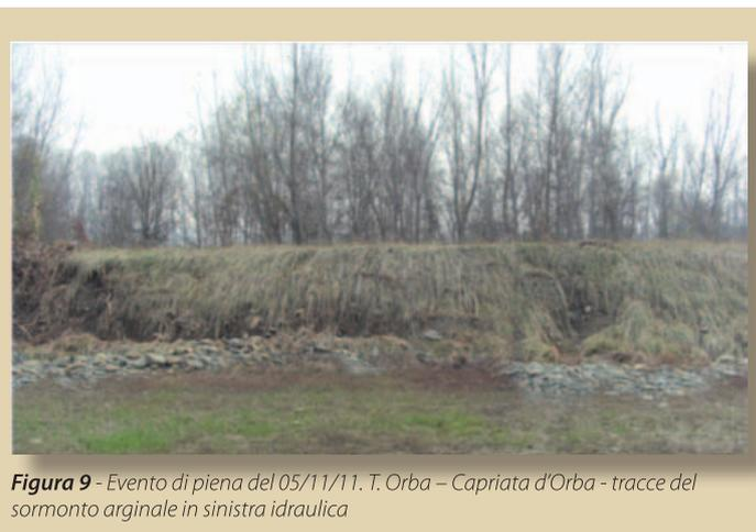
Figura 9 - Evento di piena del 05/11/11. T. Orba - Capriata d'Orba - tracce del sormonto arginale in sinistra idraulica
