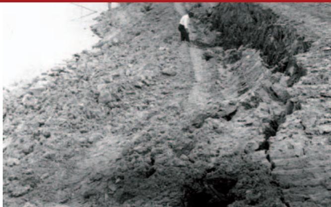
Figura 3. Foto d'archivio. Movimento franoso della porzione di arginatura a fiume nel tratto prospiciente l'abitato di Ficarolo – Magistrato per il Po, 1965.
