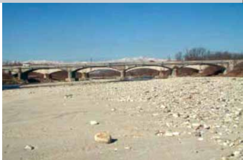
Ponte ex SS 11 sul Torrente Orco tra Brandizzo e Chivasso
