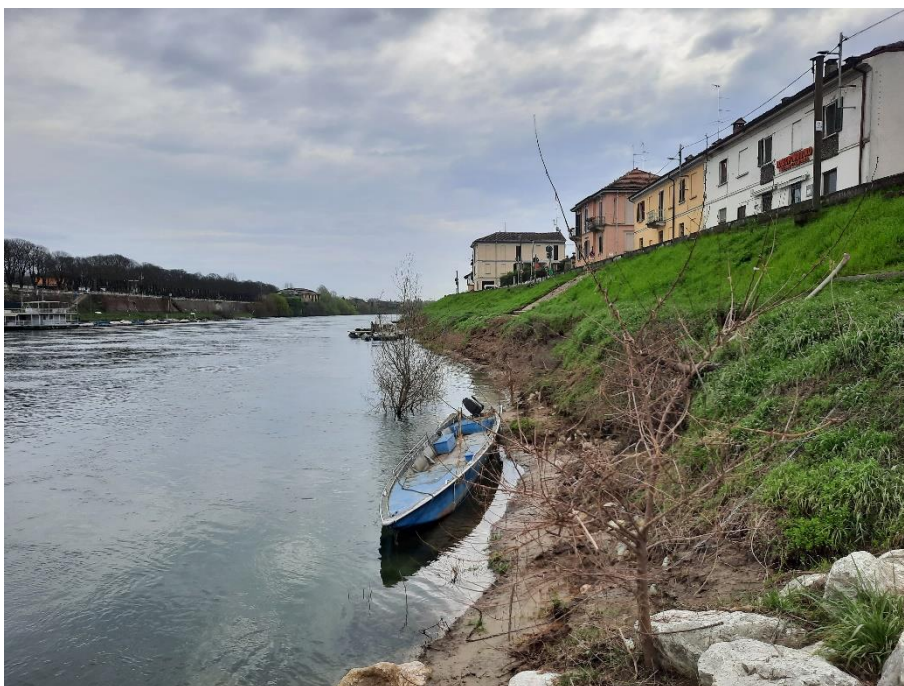
Fig.4: Stato attuale dell'erosione spondale a valle della gabbionata
