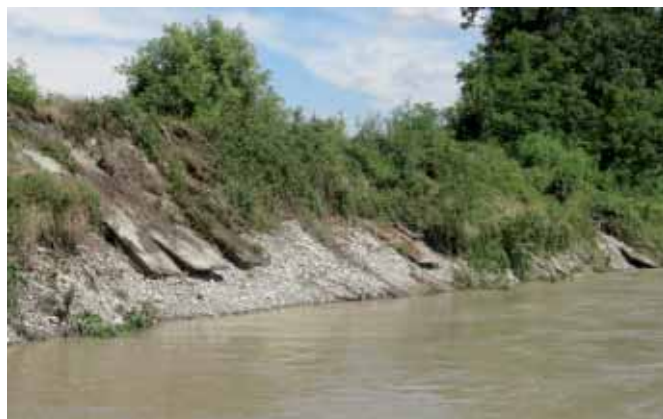
Fiume Po (Brandizzo): erosione dell'argine in froldo dopo la piena di giugno 2010
