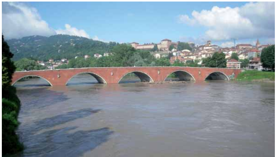
Fiume Po (Moncalieri) ponte Trieste 17 giugno
