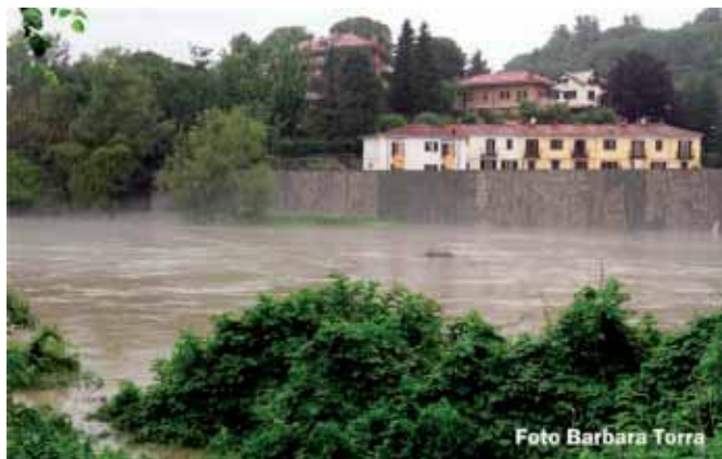
Fiume Dora B. (Ivrea): muro arginale di via Aldisio
