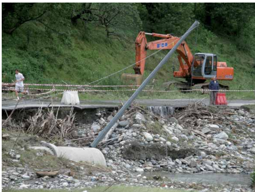
Torrente Pellice: rilevato d'accesso al Ponte della "Bertenga" - il giorno dopo
