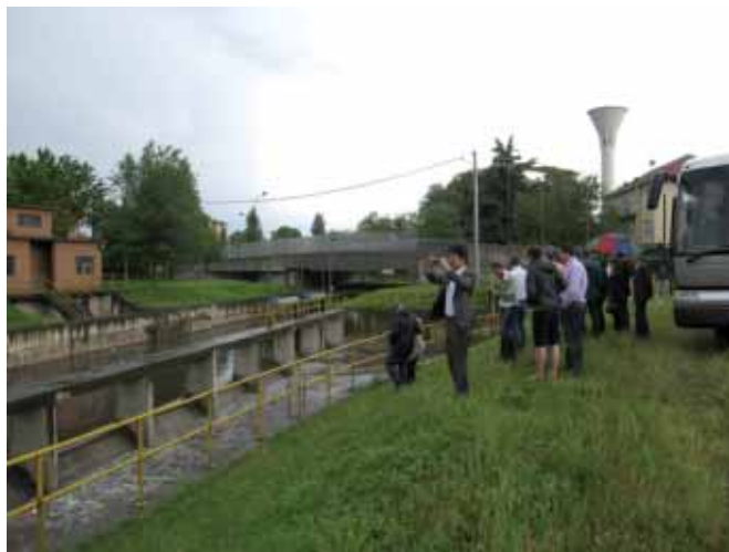
I partecipanti al Friar presso la presa Seveso
