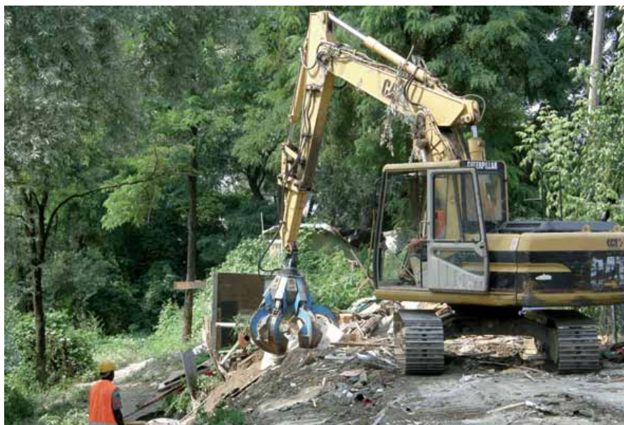
Fiume Po a Moncalieri: demolizione baracche in sponda
