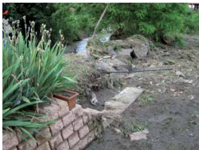
Torrente Lemina: zona di sormonto difesa spondale emergente (Pinerolo)
