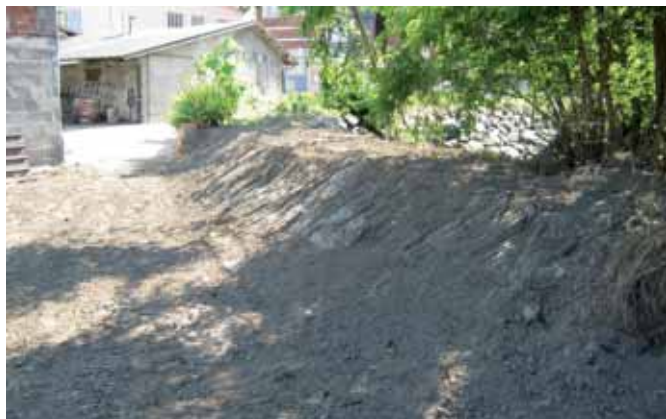
Torrente Lemina: ripristino zona di sormonto difesa spondale emergente (Pinerolo)
