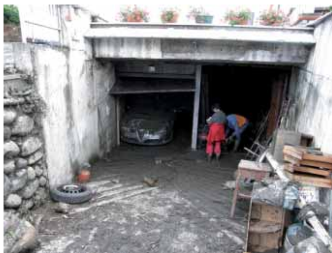
Torrente Lemina: danni alle abitazioni (Pinerolo)
