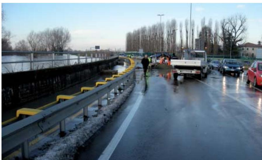
Modena, strada prov. per Carpi - Destra Secchia, il livello del fiume supera quello degli scarichi delle acque piovane, allagando la strada
