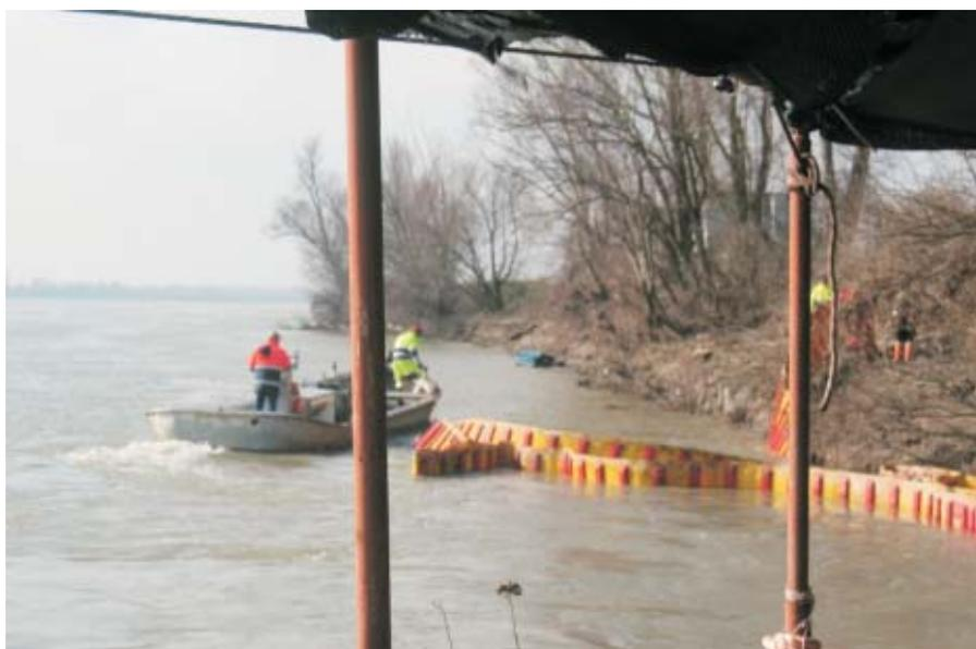
*Calto (RO), posa in opera delle barriere impermeabili*
