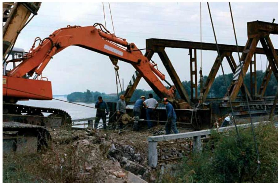
*Demolizione della spalla del vecchio ponte*
