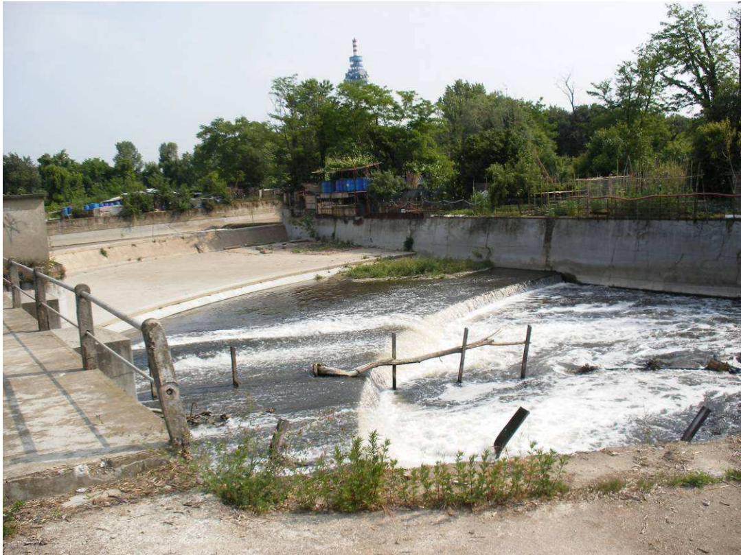
Figura 3 Accumulo dell'acqua proveniente dalle paratoie per il funzionamento dei sifoni
