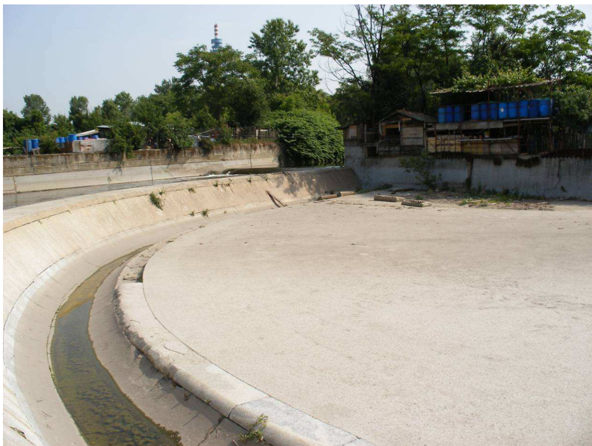
Figura 5 Il lungo sfioratore che integra il deflusso delle paratie in caso di piena
