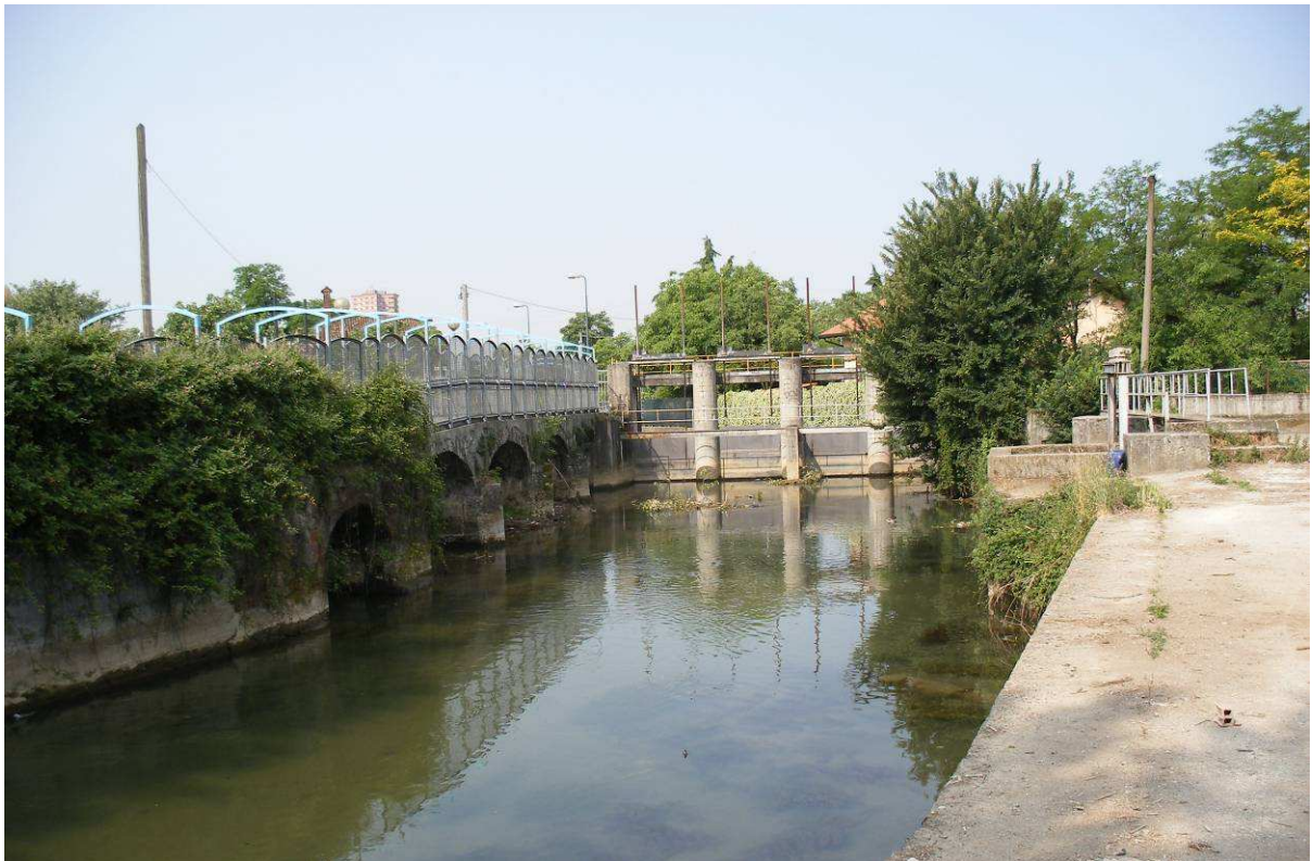
Figura 2 Canale della Martesana le cui acque provengono dall'Adda. Sotto questo tratto passano i sifoni con l'acqua del Lambro
