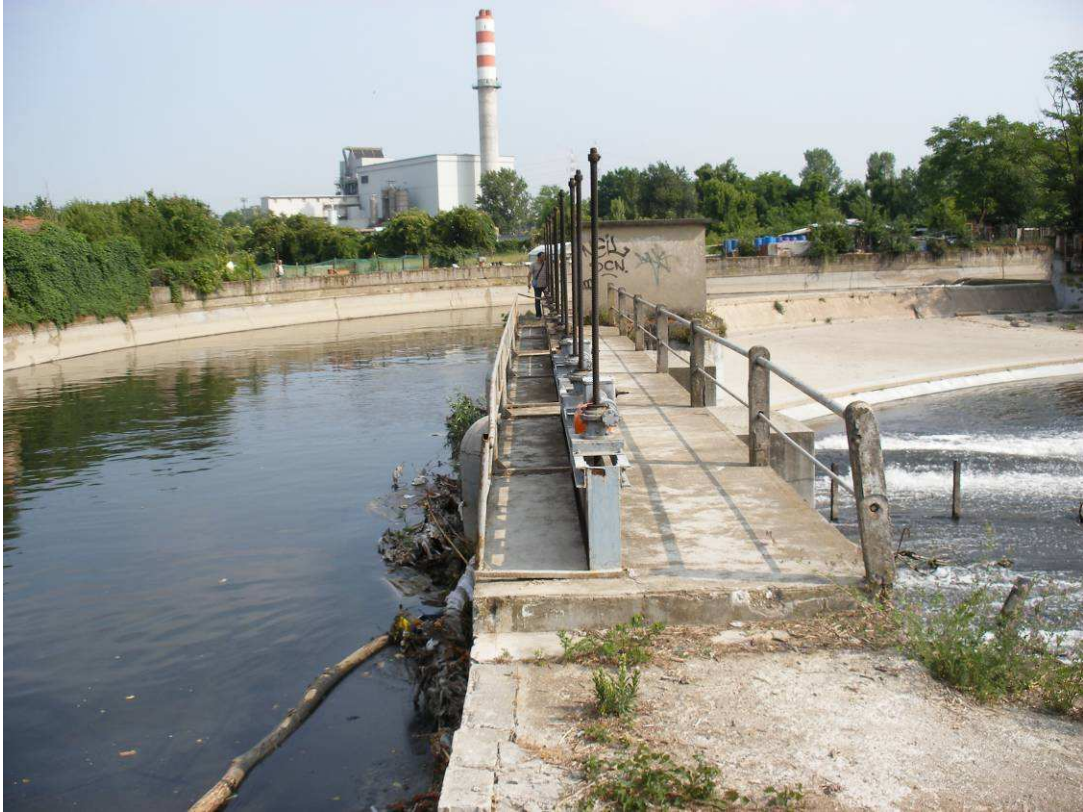
Figura 1 Vista laterale del sistema di paratoie che consente alle acque del Lambro di accumularsi nella vasca di destra prima di immettersi nel sifone
