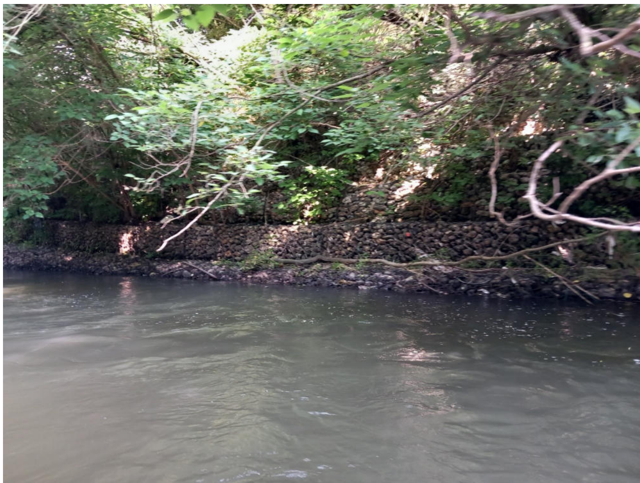
Foto 22: gabbioni in sponda sinistra nel tratto del ponte di Via Battisti
