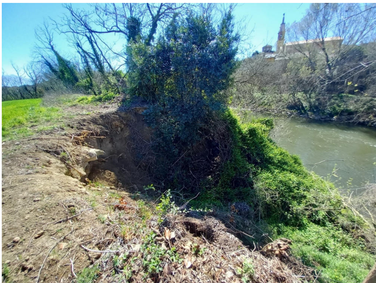
Foto 16: erosione in sponda sinistra in corrispondenza dello scarico S15 di SAL S.r.l.
