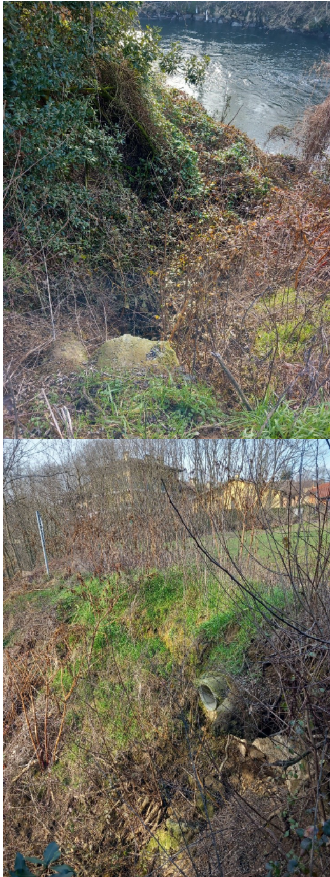
Foto 17: erosione in sponda sinistra in corrispondenza dello scarico S15 di SAL S.r.l.
