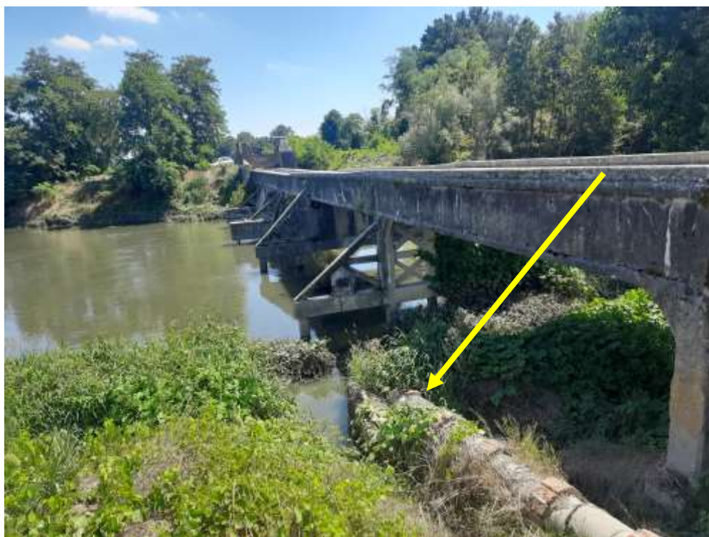
Vista a valle del ponte canale su sponda sx fiume Lambro con individuazione scarico idraulico
