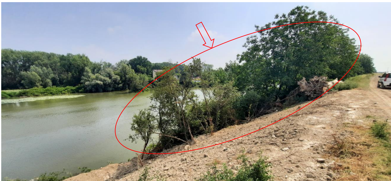
Figura 4 – Vegetazione spontanea occultante e cresciuta sull'opera idraulica.
