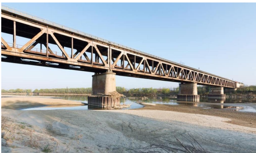
Figura 4. Il ponte sul Po di tipo misto ferroviario-stradale di Bressana in Provincia di Pavia
