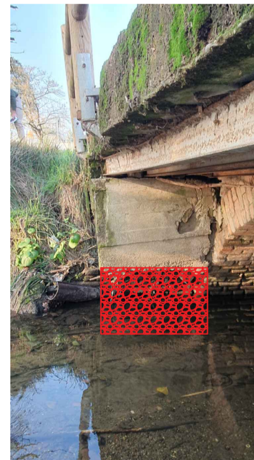
Sistemazione blocco di fondazione con corrazzamenti in pietra
