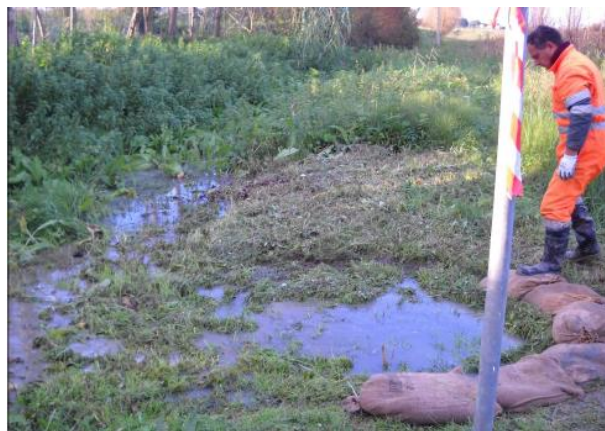
Figura 4.3 Evento di piena 2019: fenomeni filtrazione e fontanazzi presso il centro di Mazzorno Sin. e loc. Casa Borella (Erbacci et al., 2022)
