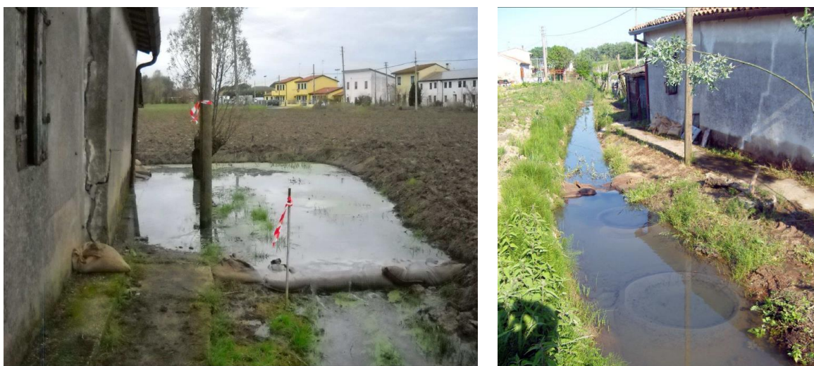
Figura 4.2 Evento di piena 2019: fontanazzi e fenomeni filtrazione presso Mazzorno Sin., autorimessa Orlandi (Erbacci et al. 2022)
