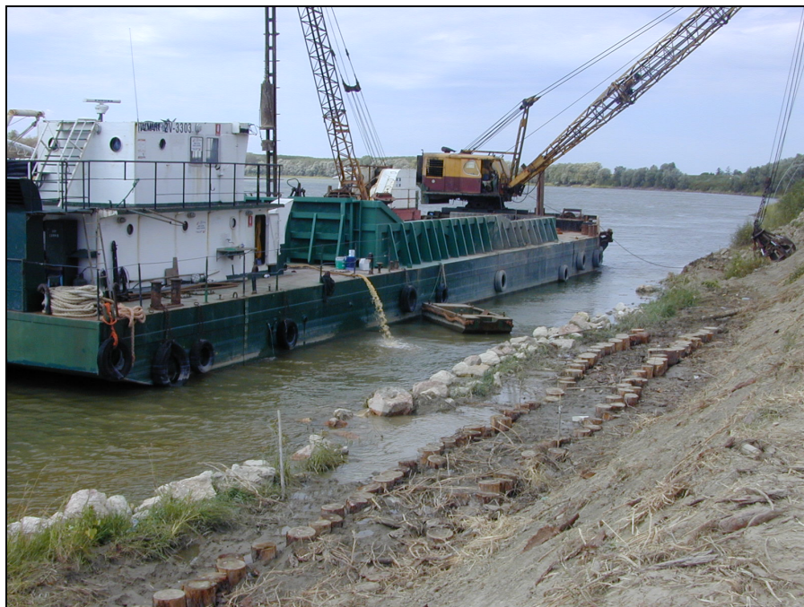
Figura 19 - Particolare della palificata in legno realizzata nell'anno 2003 nell'ambito dell'intervento di classifica RO-E-1382 "Lavori di somma urgenza per la messa in sicurezza dell'arginatura maestra in sinistra Po fra gli stanti 354-355 – IV T.C. nel comune di Guarda Veneta"- posizionamento della palificata al piede di frana.
