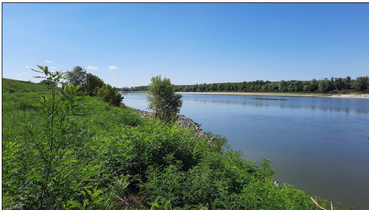
Figura 17 – Luglio 2022 –dissesto immediatamente a monte dello stante 211 (vista da monte) – la pronunciata magra estiva evidenzia l’accumulo di pietrame al piede della scarpata di sponda.
