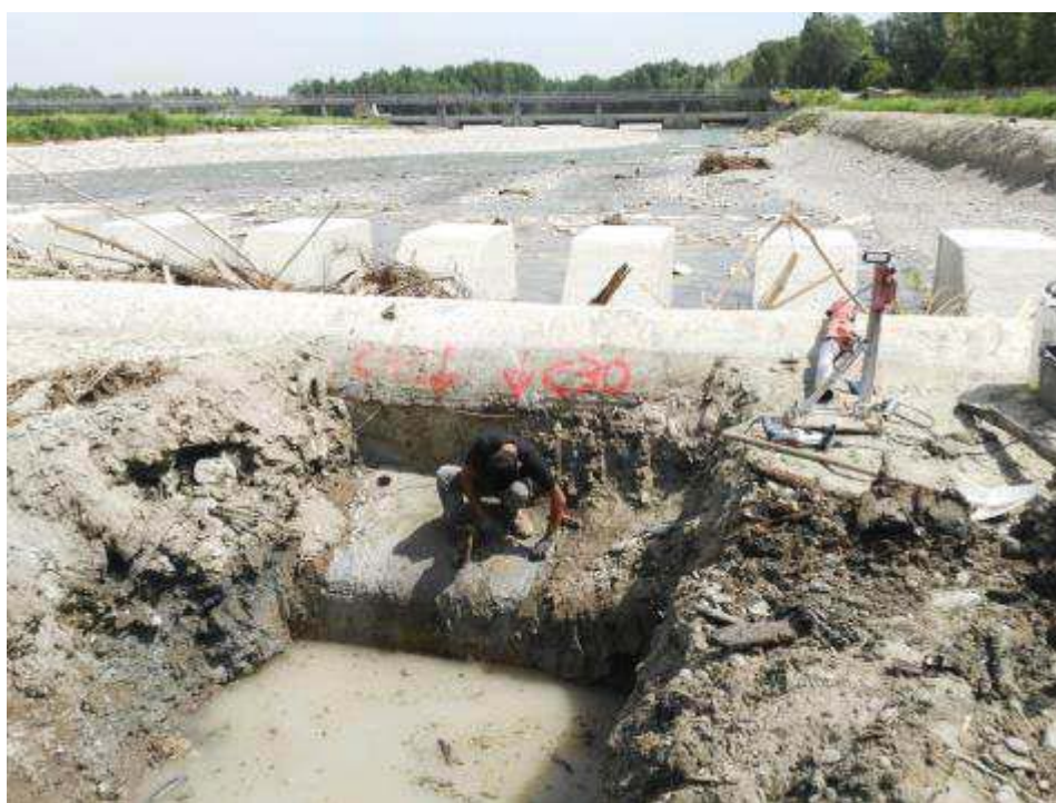
Foto 53. Traversa di Monte. Saggio in fondazione sponda destra
