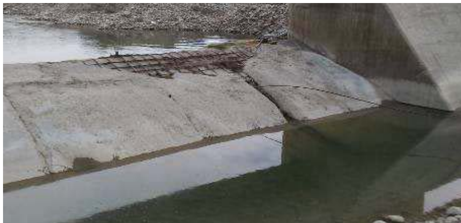
Foto 40. Prelievo ferri esposti. Manufatto limitatore di Monte
