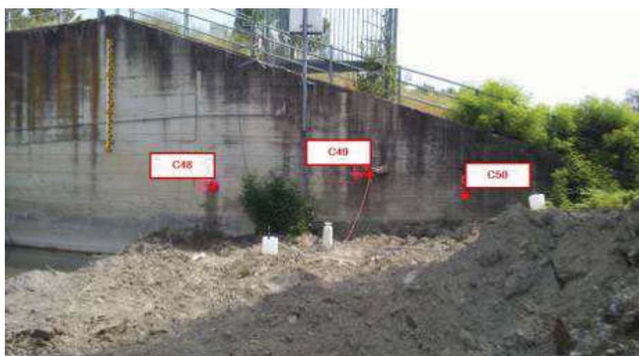
Foto 25. Manufatto limitatore di Valle. Evidenziati in rosso i prelievi delle carote
