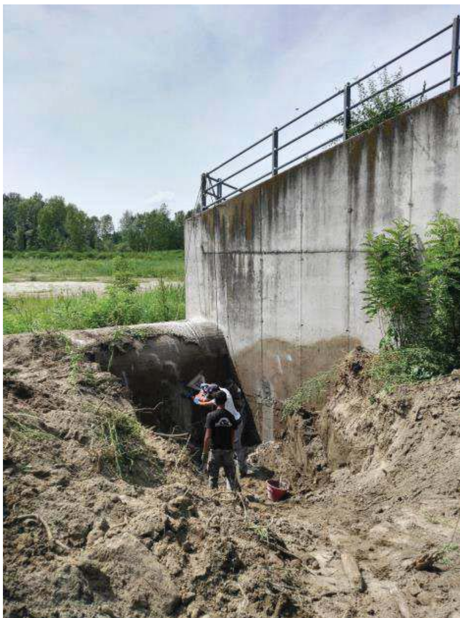
Foto 57. Manufatto limitatore di monte. Sfioro di troppo pieno. Saggio in fondazione
