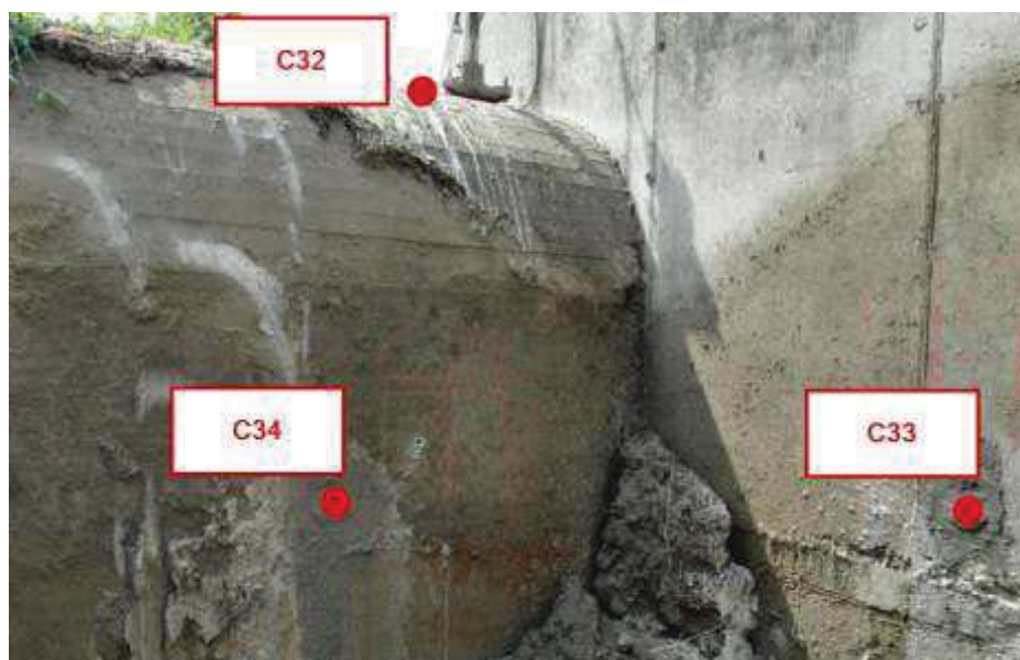
Foto 17. Manufatto limitatore di Monte. Evidenziati in rosso i prelievi delle carote
