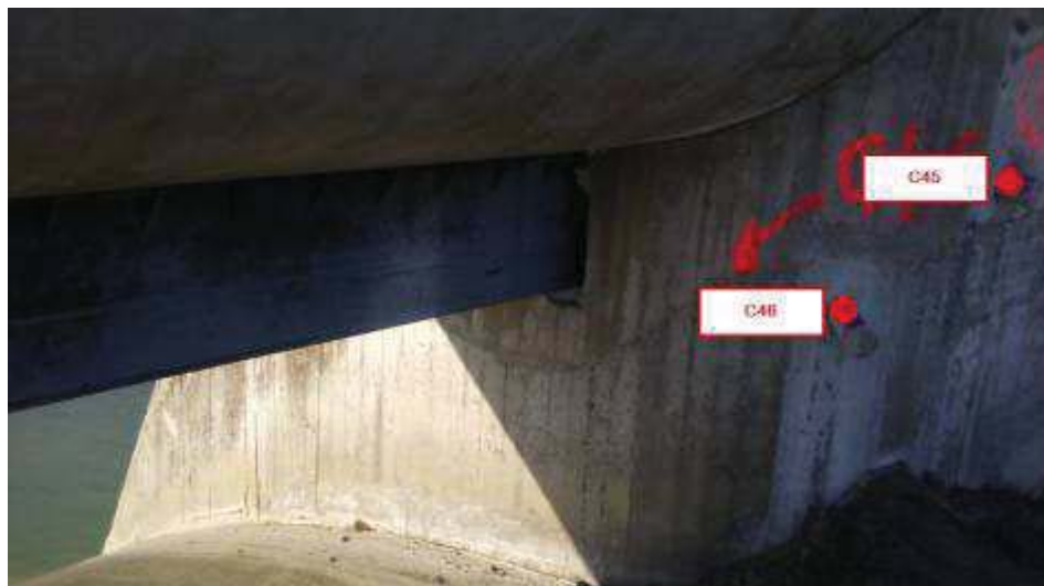
Foto 24. Manufatto limitatore di Valle. Evidenziati in rosso i prelievi delle carote
