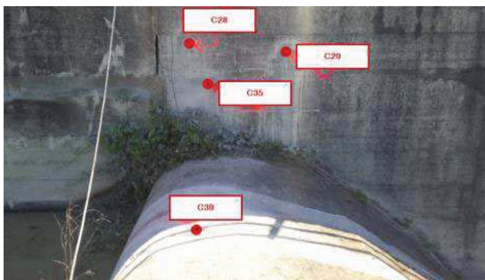
Foto 21. Manufatto limitatore di Valle. Evidenziati in rosso i prelievi delle carote
