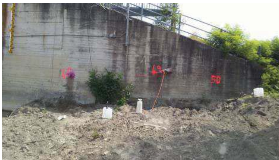
Foto 62. Manufatto limitatore di valle. Sfioro di ingresso cassa. Saggio in fondazione spalla destra
