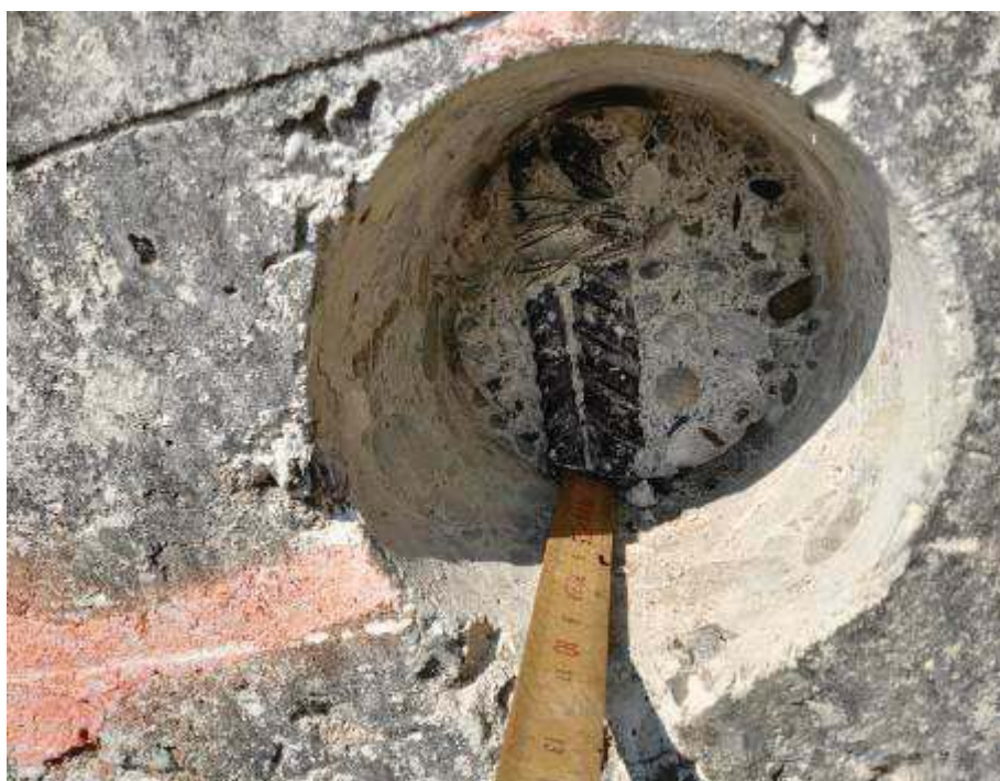
Foto 42. Manufatto limitatore di Valle. Spalla destra. Misura copriferro reale
