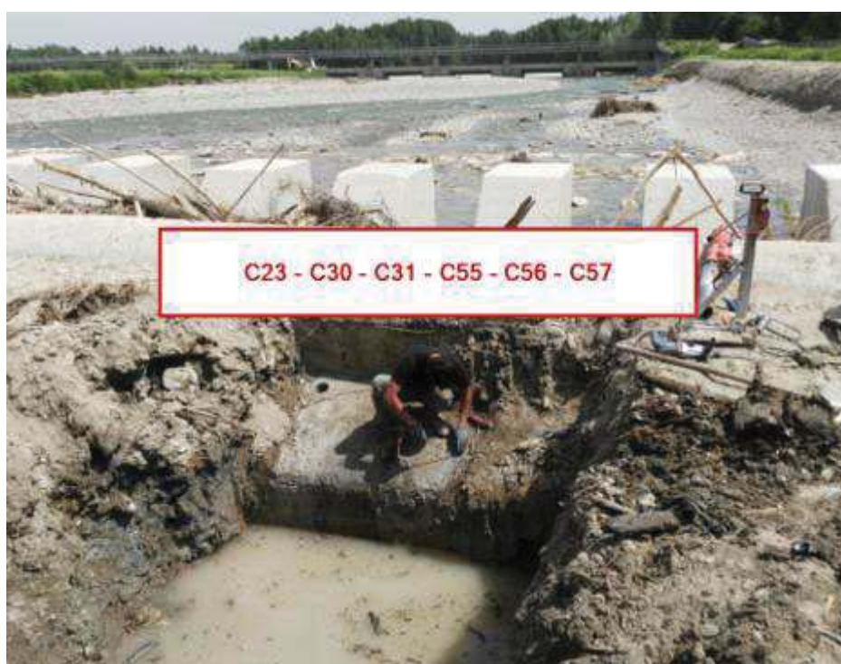
Foto 13. Traversa di Monte. Esecuzione prelievi carote in fondazione
