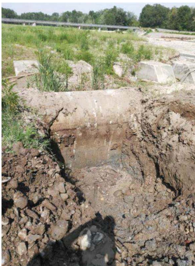
Figura 10: Saggio in fondazione sponda sinistra
