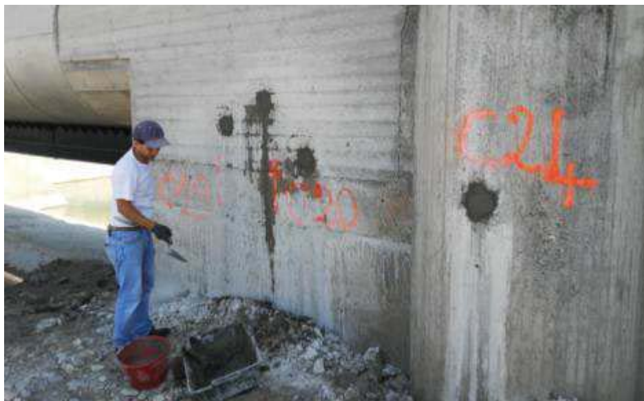
Foto 34. Manufatto limitatore di Monte. Fase di ripristino fori
