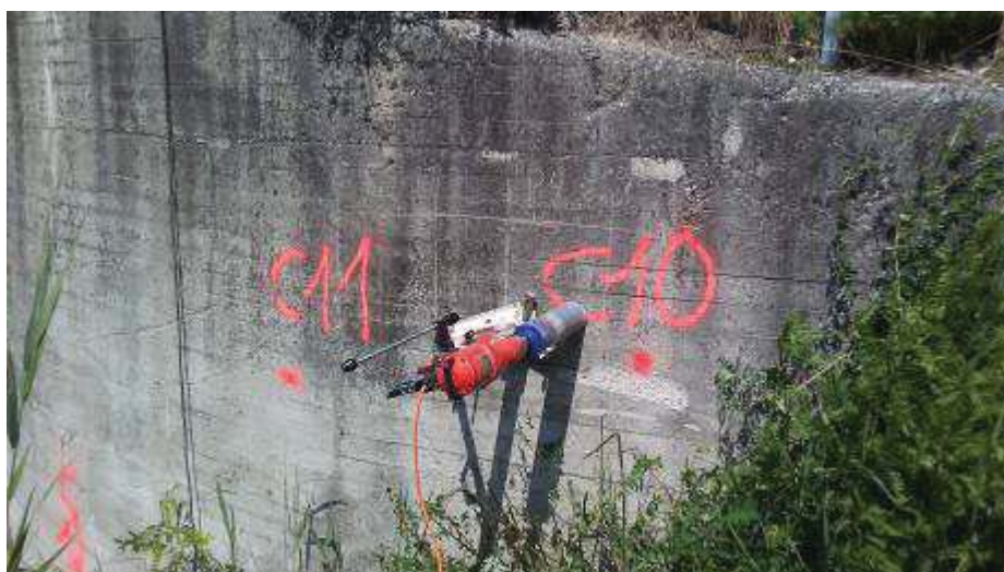
Foto 31. Manufatto limitatore di Monte. Esecuzione carotaggi spalla sinistra
