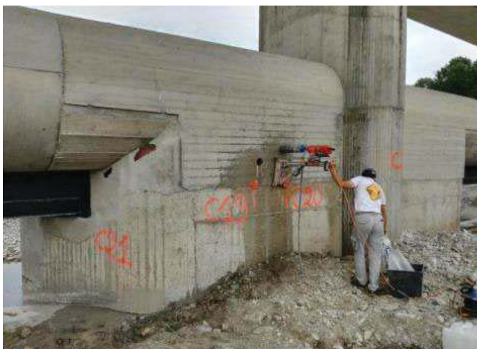
Foto 59. Manufatto limitatore di monte. Manufatto in alveo. Saggio in fondazione
