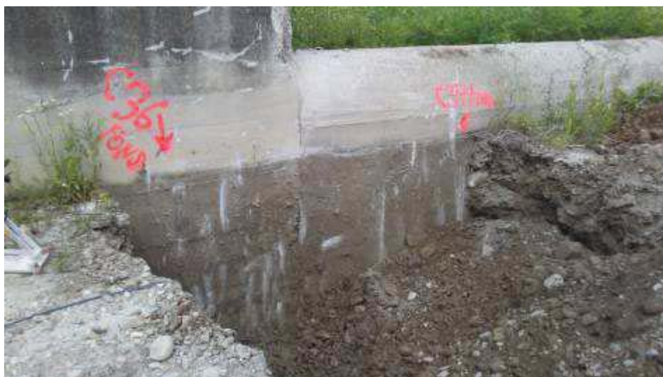
Foto 60. Manufatto limitatore di valle. Sfioro troppo pieno. Saggio in fondazione
