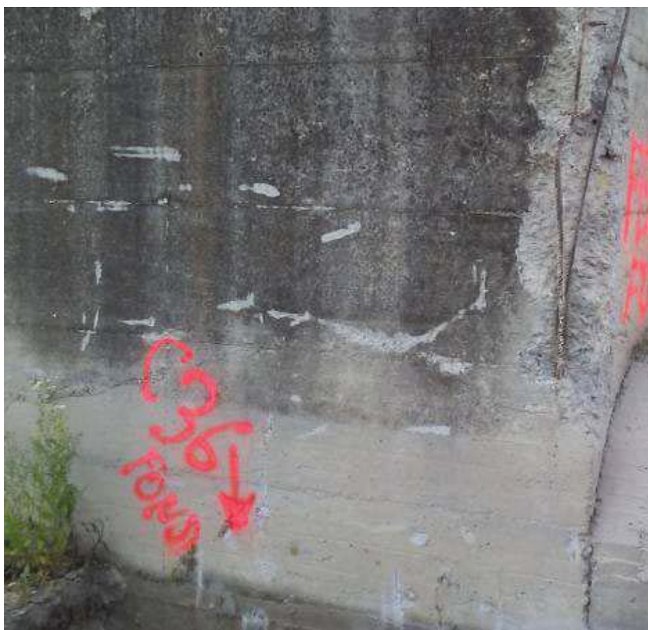
Foto 41. Prelievo ferri esposti. Manufatto limitatore di Valle
