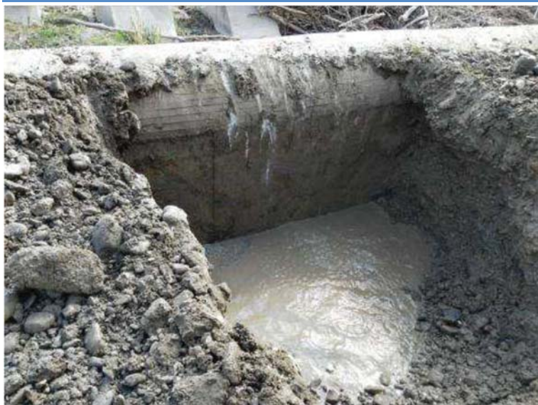
Figura 9: Saggio in fondazione sponda sinistra
