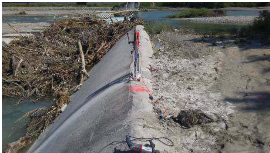
Foto 30. Traversa di Monte. Esecuzione carotaggi protezione
