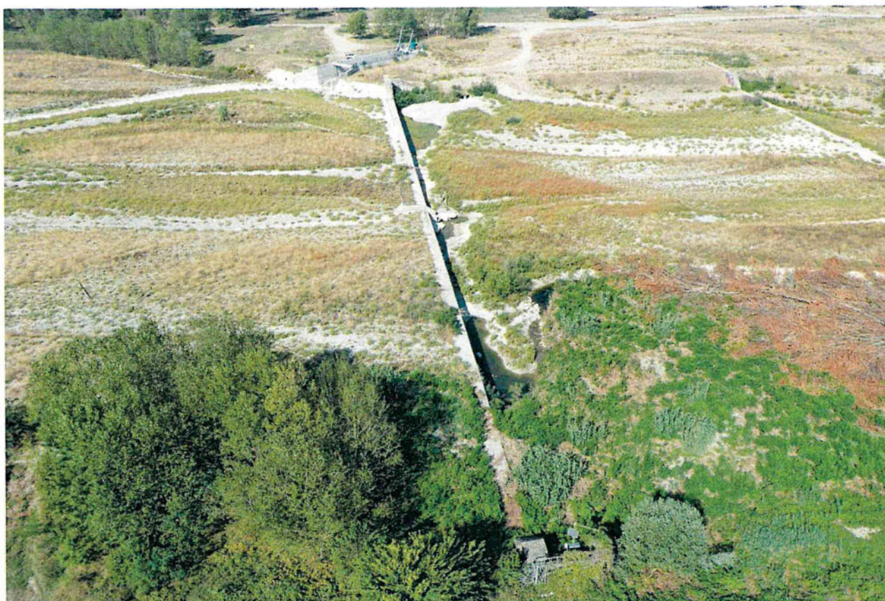
Figura 2 Vista da ripresa aerea con drone della prima briglia di monte. In sponda sinistra è presente il manufatto di presa della centralina idroelettrica.
