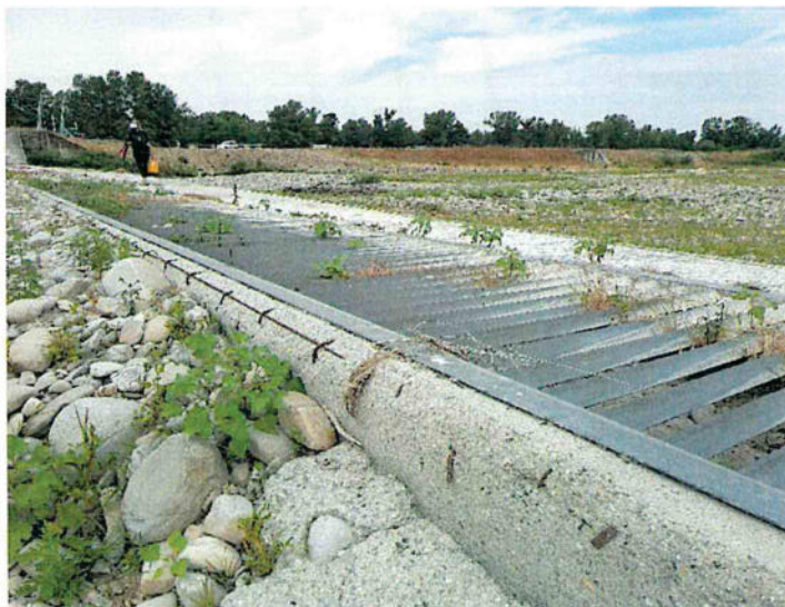
Figura 5 Manufatto di presa centralina idroelettrica dotato di griglia, oggi totalmente ostruita da materiale lapideo
