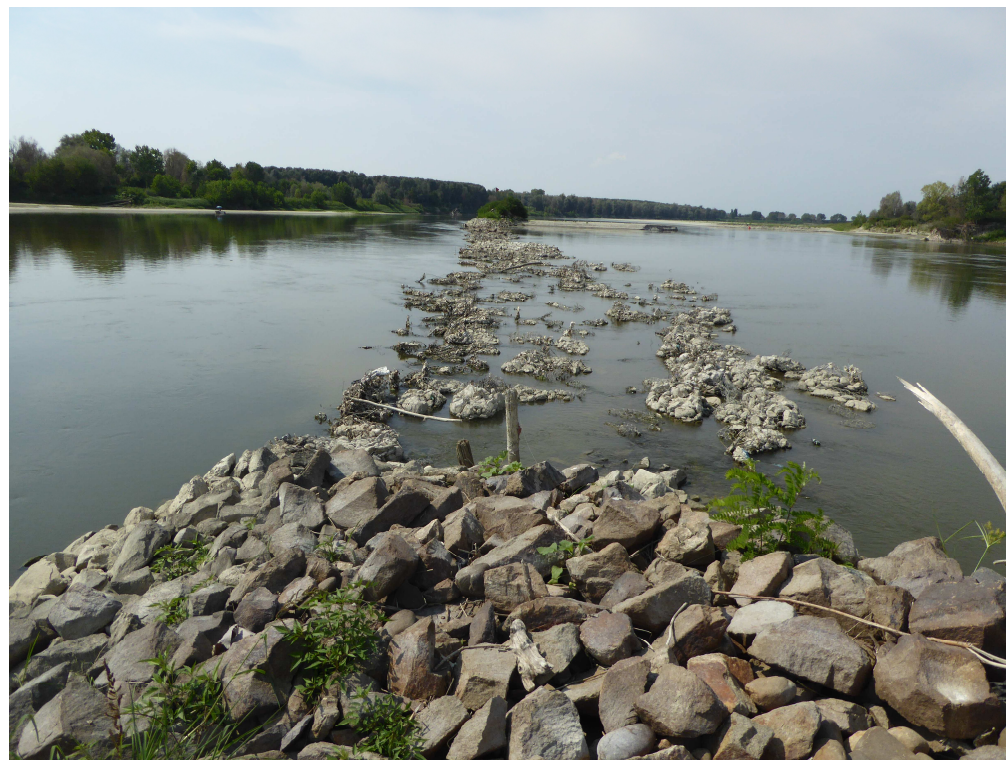
Foto 4 : Immagine del pennello al termine dell'intervento di somma urgenza
