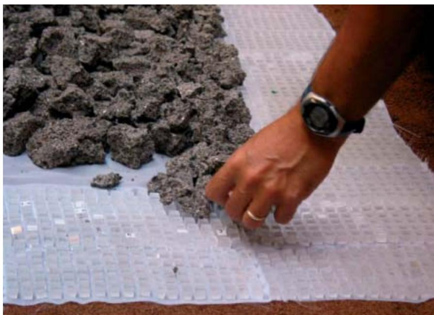
Figura 8 - Una fase della realizzazione di un pennello flessibile
