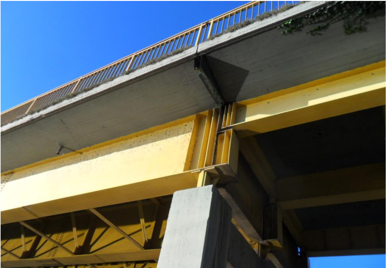
Figura 4 – Dettaglio di appoggio della campata di riva
