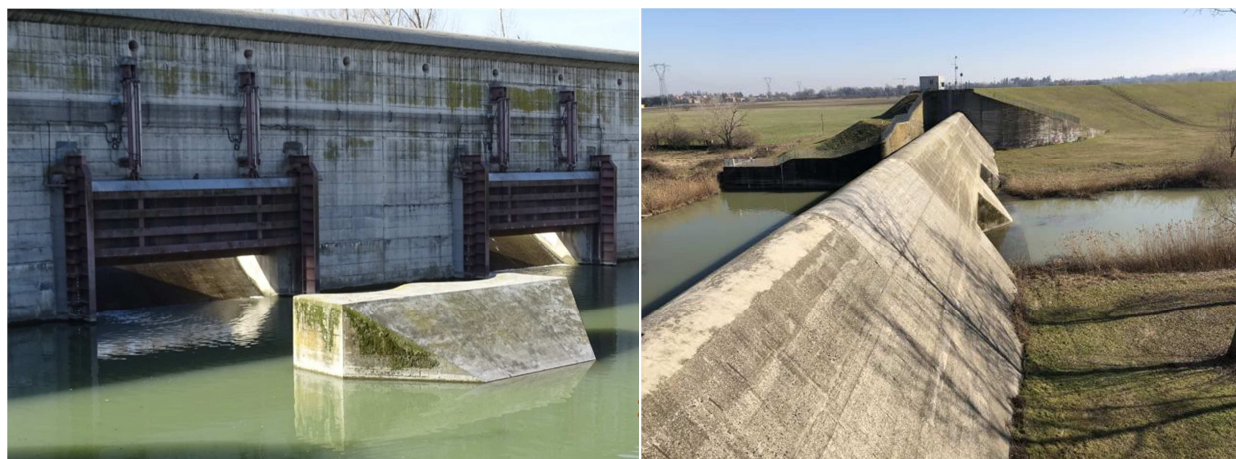
Figura 6: Paramento di valle in sx e paramento di monte in dx
