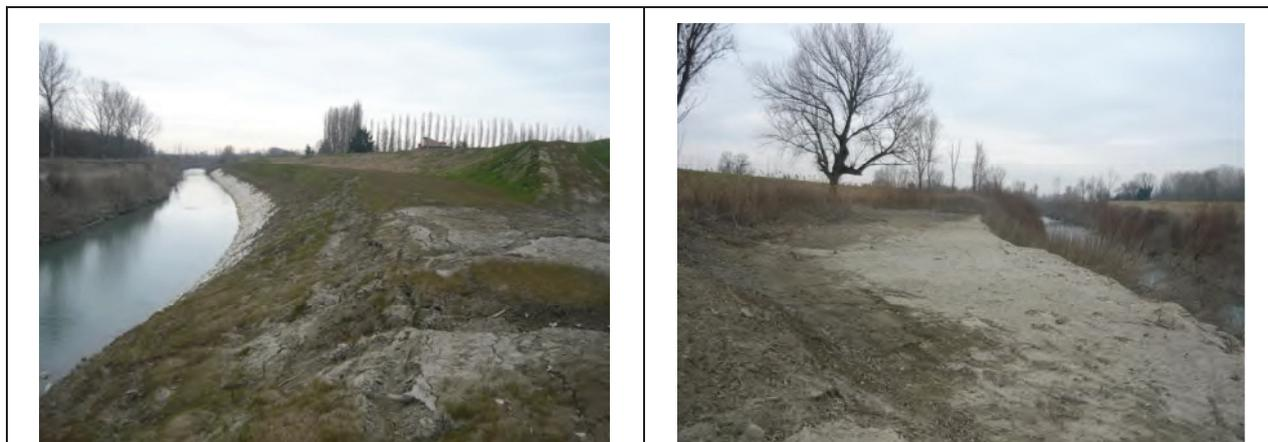
**Fig. 13 Intervento di consolidamento al piede lungo la sponda destra (stante 64 in dx) e riprofilatura in sponda sinistra all'altezza della C. Cassai**
