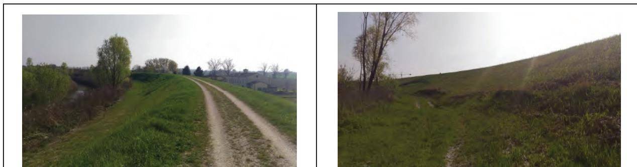
**Fig. 28** Cedimento paramento rilevato arginale lato fiume allo stante 228 in foto sx e allo stante 233, nell'immagine a destra
