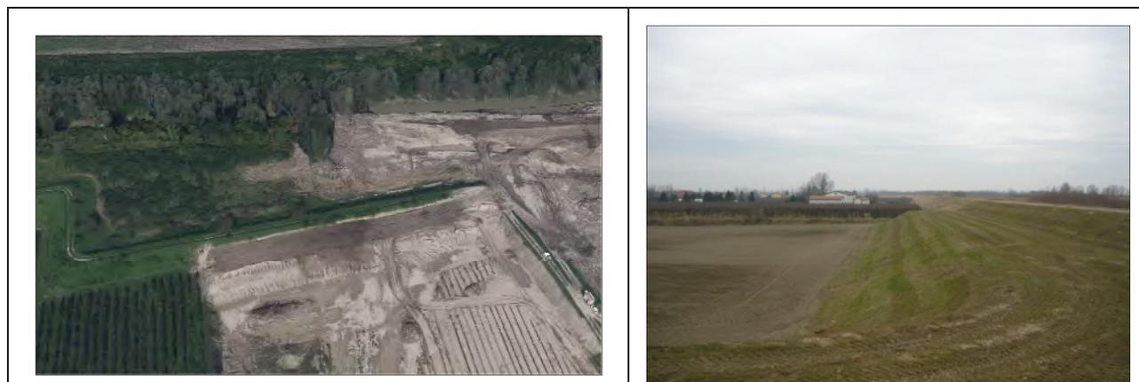
**Fig. 17** Realizzazione di una banca lato campagna lungo l'argine in destra in località C. Cantone
