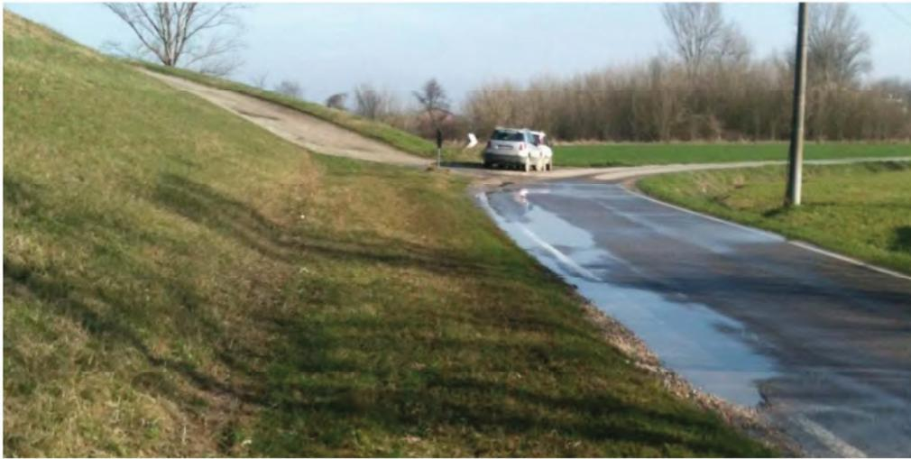
**Fig. 25 Filtrazione tratto di argine stante 131-133 lato campagna lungo la sede stradale a seguito evento alluvionale del 2014**
