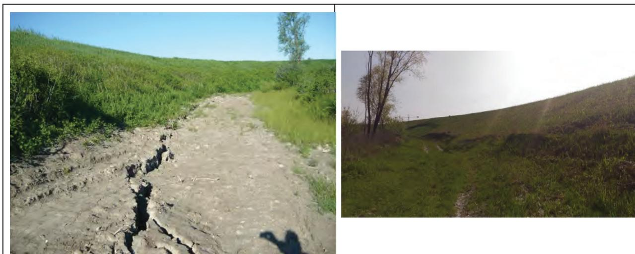
**Fig. 2** Cedimento della banchina lato fiume (stante 240 AIPO in sx) e della scarpata lato fiume (stante 233-234 in dx) emerse nelle verifiche in campo
