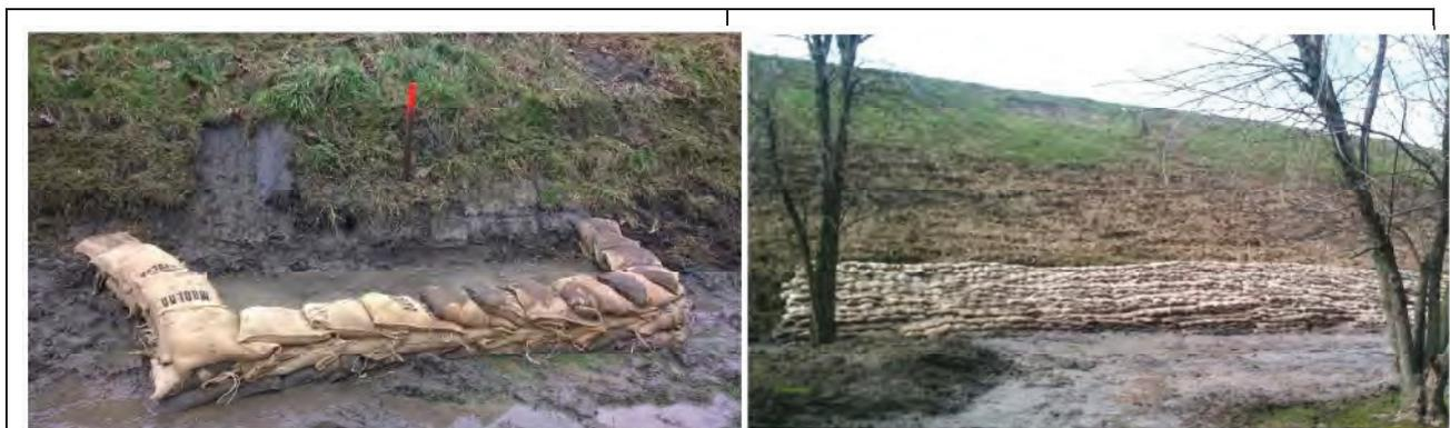
**Fig. 30 Imbancamento con sacchetti di sabbia eseguito al piede dell'argine in data 08/02/2014 in via Rebutina stante 165-166**
