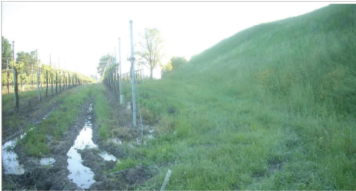
**Fig. 21** Infiltrazione lato campagna lungo l'argine in destra idrografica in località C. Cavazzuti
