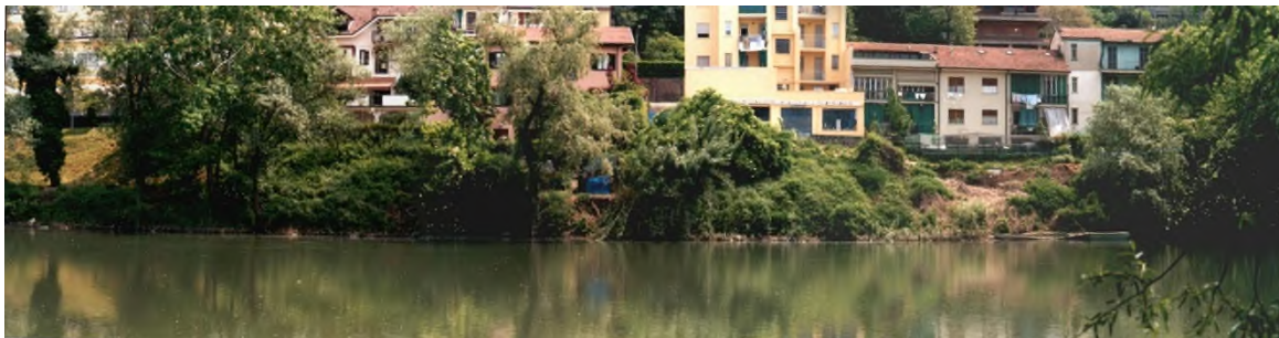
Figura 5 - Tratto in sponda destra con evidenze di erosione spondale.
