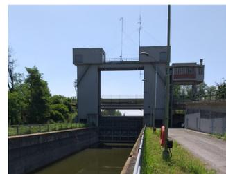
Progettazione esecutiva e coordinamento per la sicurezza in fase di progettazione per la sostituzione del meccanismo a fune di chiusura delle porte di valle della conca di navigazione di Cremona con nuovo meccanismo oleodinamico
