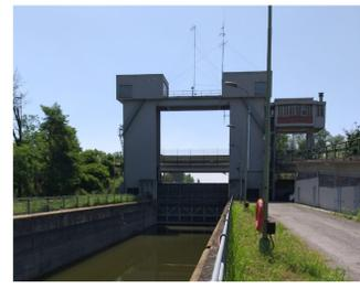
Progettazione esecutiva e coordinamento per la sicurezza in fase di progettazione per la sostituzione del meccanismo a fune di chiusura delle porte di valle della conca di navigazione di Cremona con nuovo meccanismo oleodinamico
