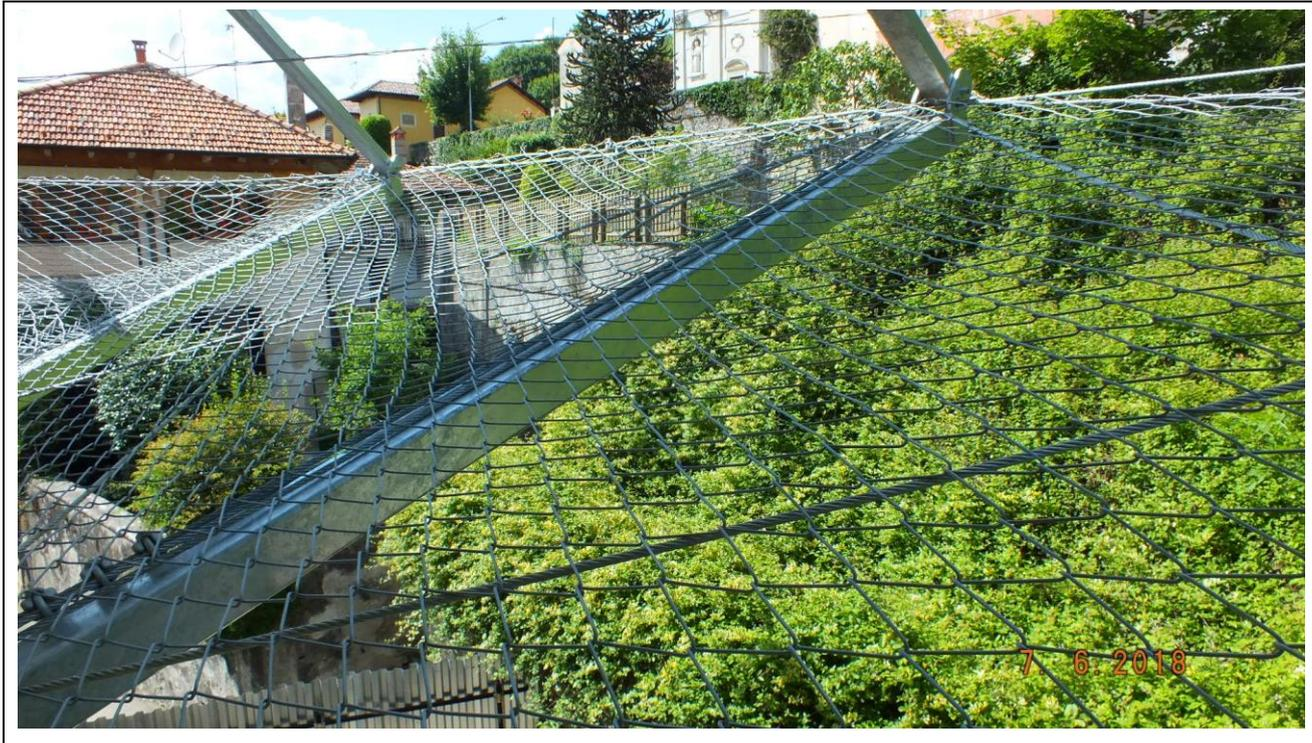
In particolare, nella foto seguente, si osserva la sovrapposizione tra la rete portante e la rete secondaria di protezione dalla caduta di elementi anche di modestissime dimensioni mentre si possono ben notare i dissipatori costituiti da anelli di funi morsettate su se stesse.
