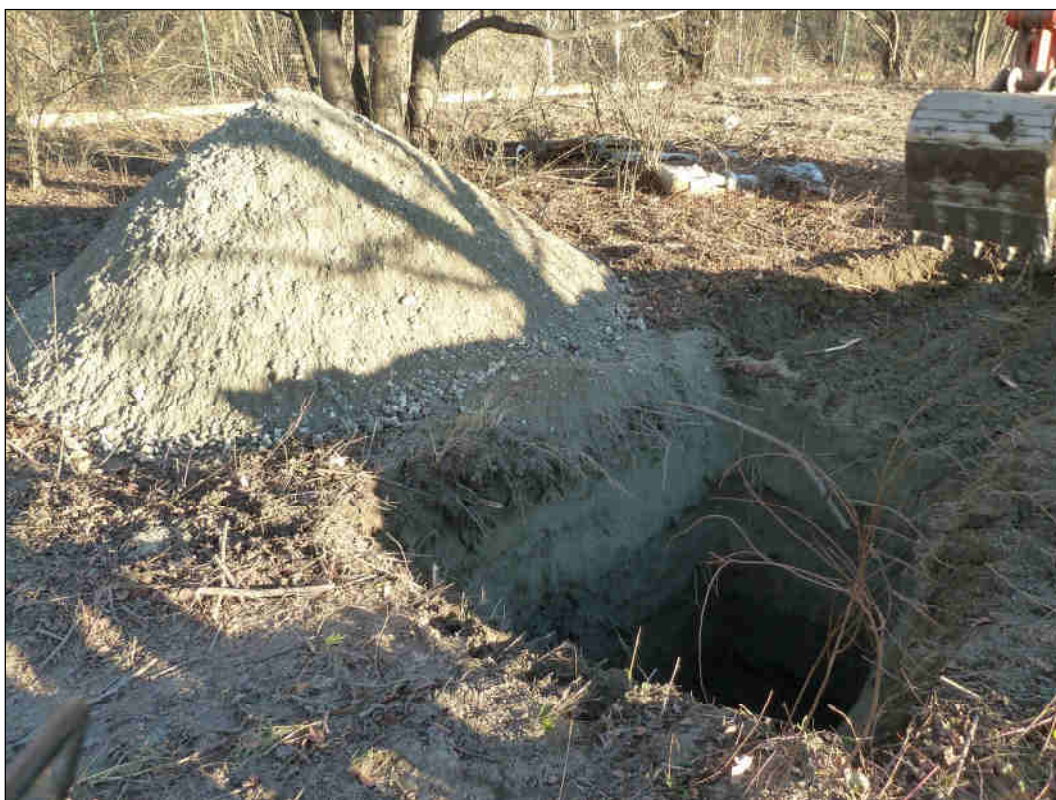
Foto 2 – Pozzetto n. 2. Livelli sabbiosi
