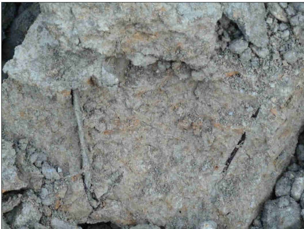
Foto 3 – Pozzetto n. 4. Riporto superficiale
