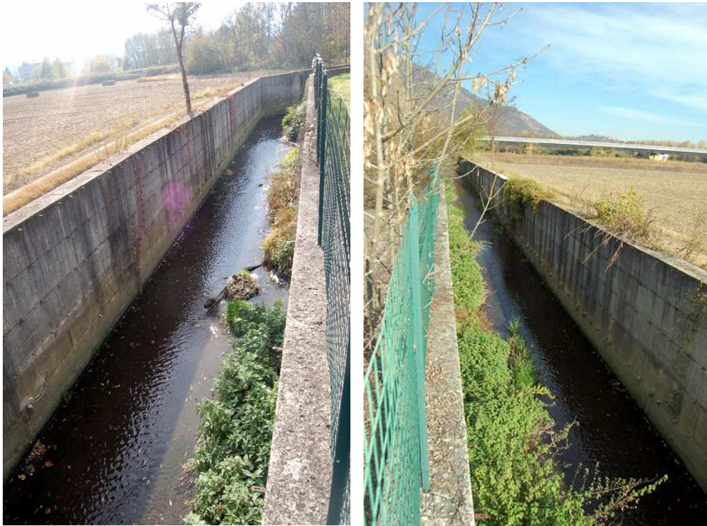
Fig. 19 – Tratto L – P, veduta del canale scaricatore da N e da S, sullo sfondo l’autostrada del Frejus.
