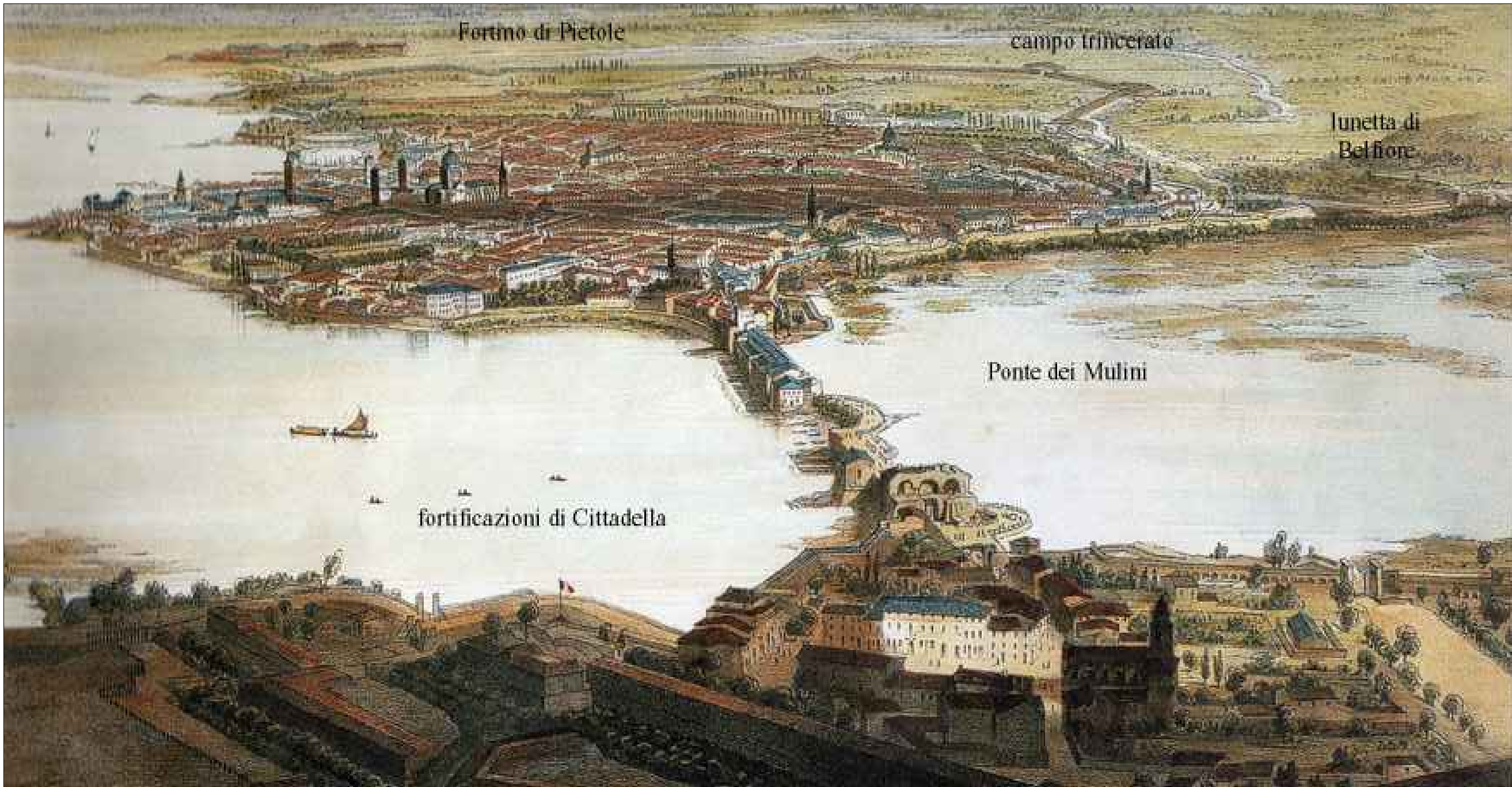
Vista del Ponte dei Mulini e della Città di Mantova da Cittadella (1854)
