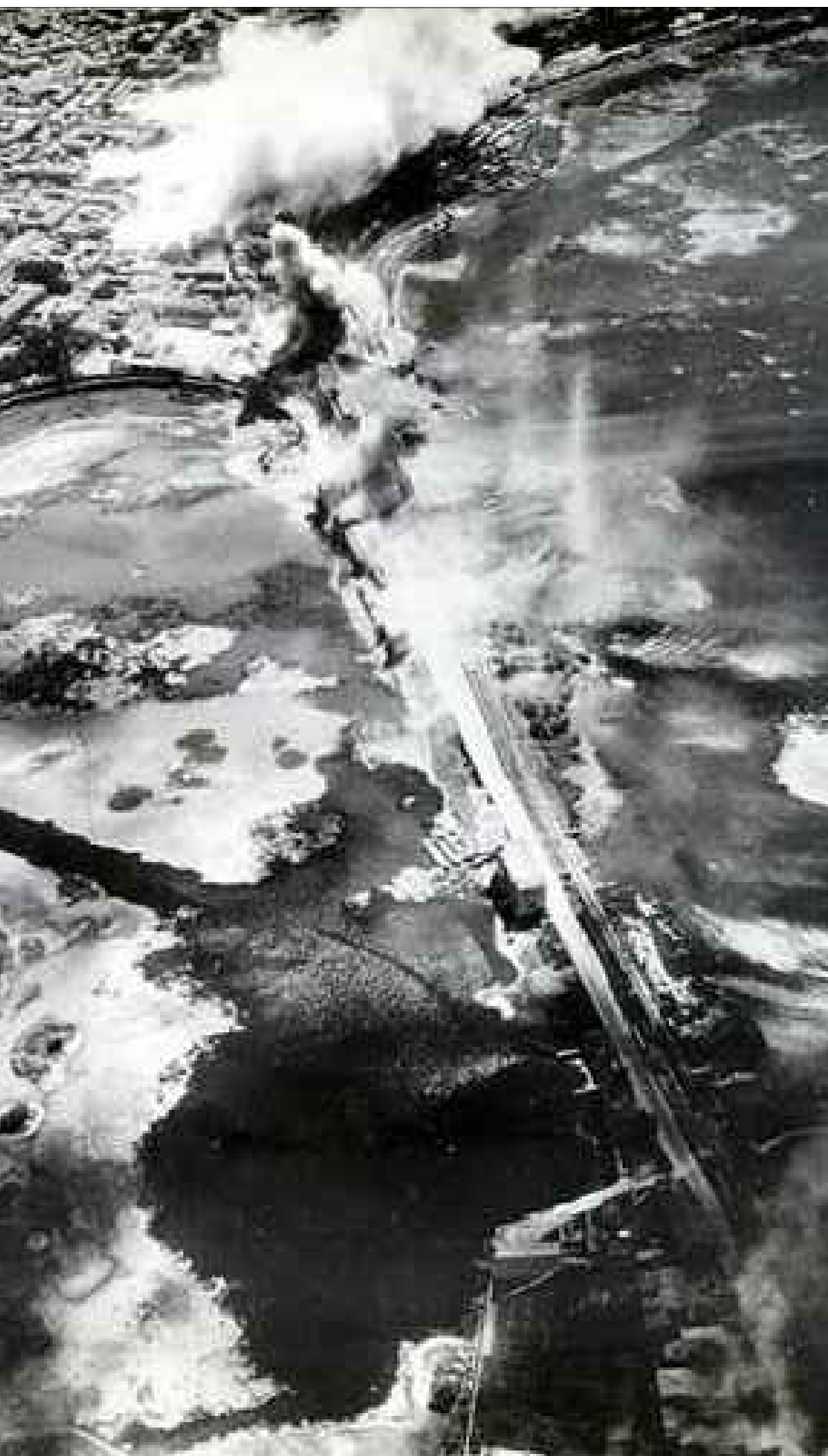
Ponte dei Mulini, bombardamento (dicembre 1944)
