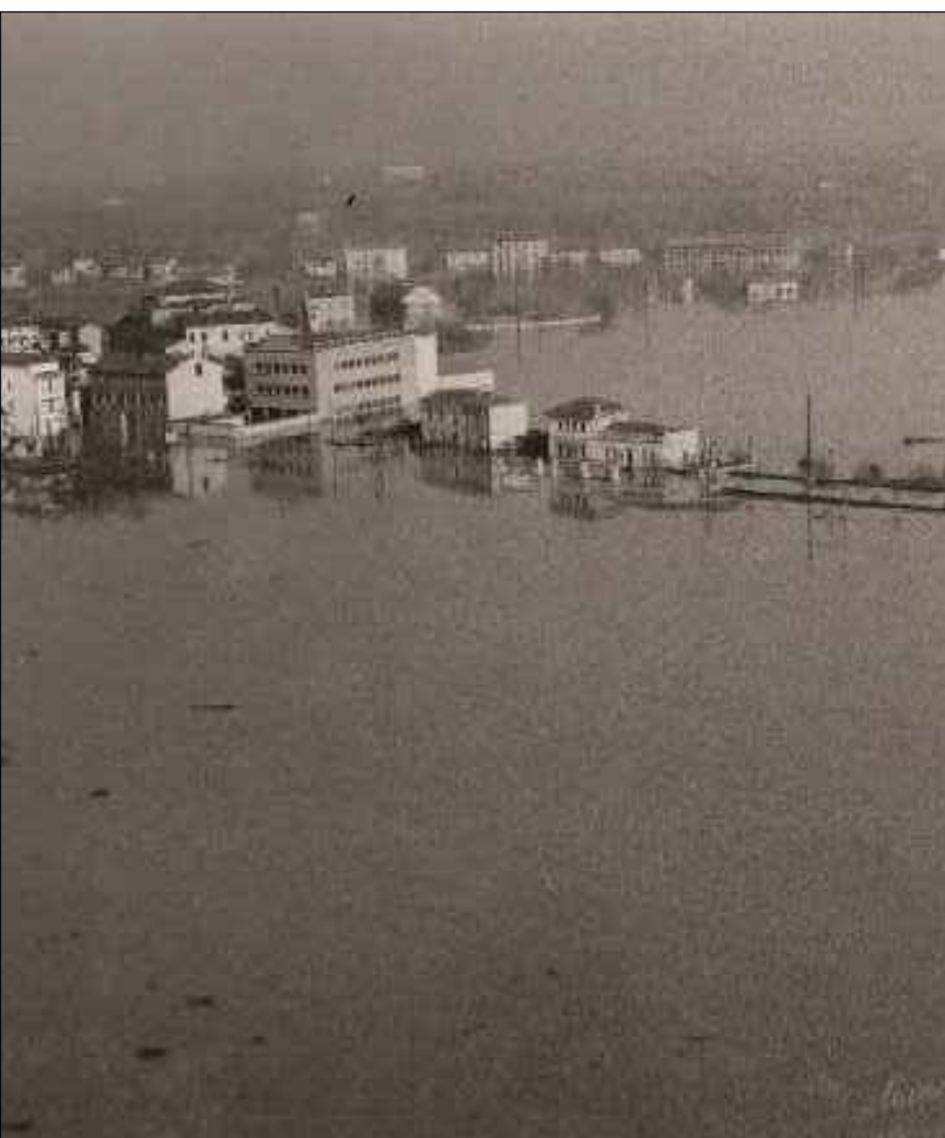
Ponte dei Mulini, alluvione (1951)
