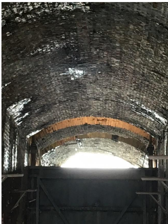
Volta di copertura in mattoni dei canali di scarico minori
