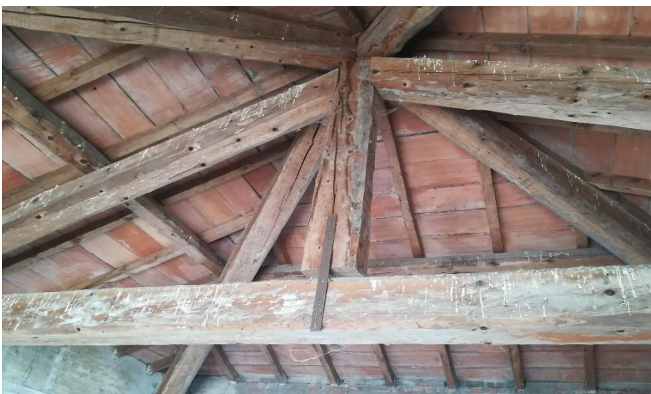
Solaio di copertura in legno e laterizio del locale di alloggiamento della paratoia principale
