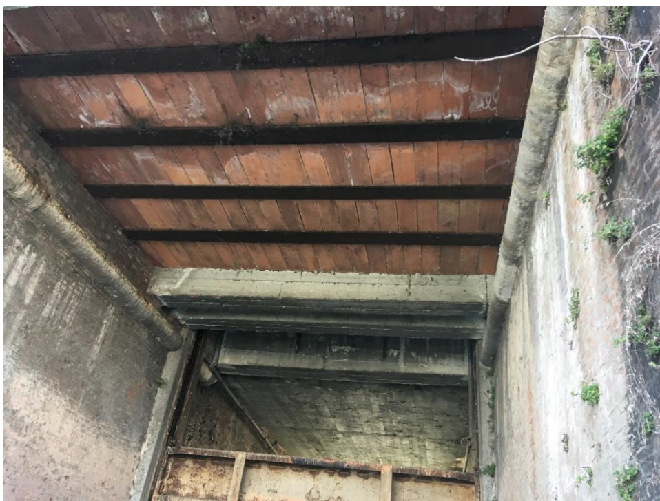
Solaio di copertura in acciaio e laterizio del canale di scarico principale
