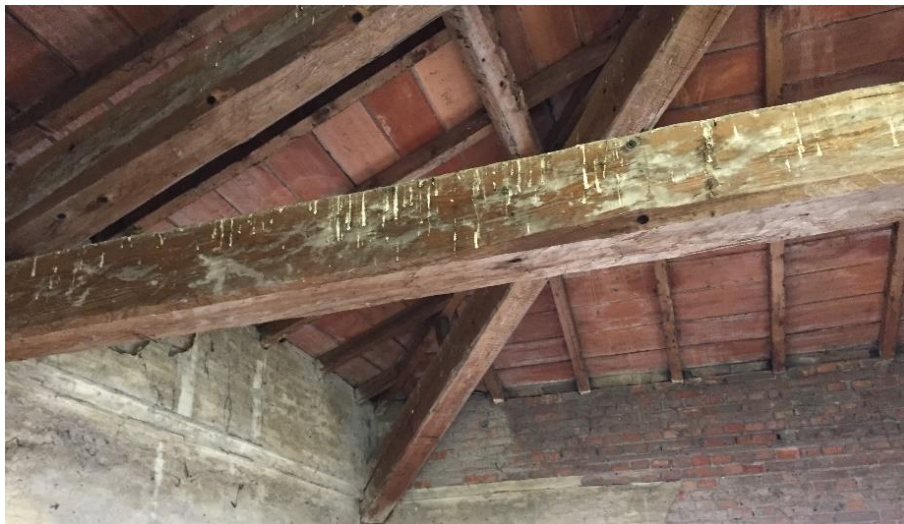
Struttura di copertura in legno e laterizio
