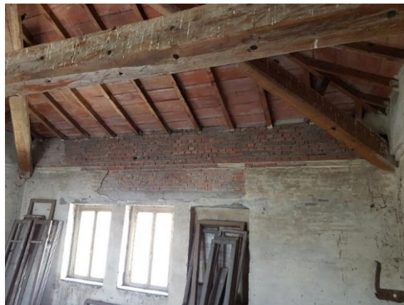
Tamponamento delle aperture originarie
