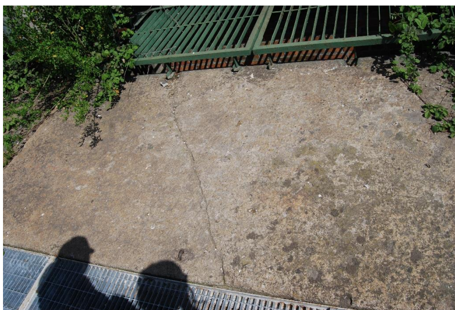
Pavimento in pietra naturale
