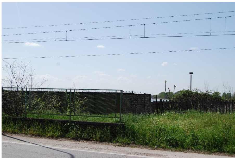
Recinzione in rete metallica in Sx idraulica
