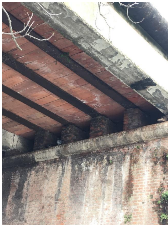
Solaio in acciaio e laterizio del canale di scarico principale
