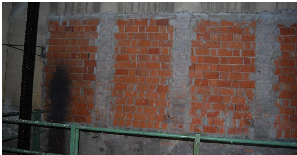
Tamponamento delle aperture originarie con elementi in laterizio semipieno
