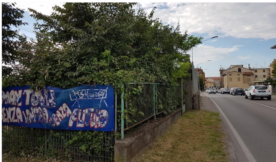
Recinzione in pannelli in acciaio elettrosaldati in Dx idraulica
