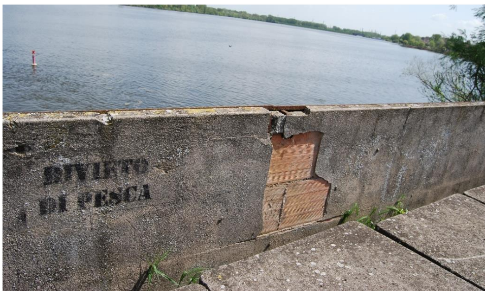
Parapetto in corrispondenza del cunicolo TEA S.p.a.
