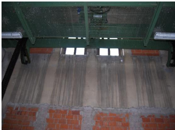
Tamponamento delle aperture originarie
