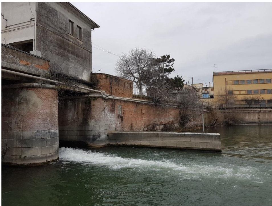
Canale di scarico principale e dissipatore in Sx idraulica visti dal Lago di Mezzo
