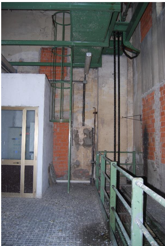
Tamponamento delle aperture originarie
