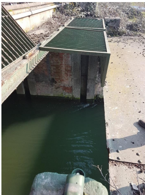
Pilastro esistente in sponda destra del pancone PM3
