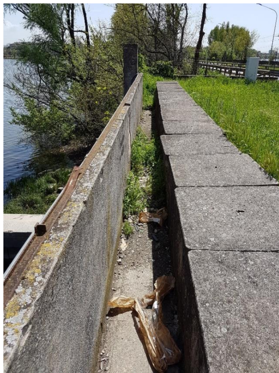
Cunicolo di alloggiamento della tubazione TEA S.p.a.
