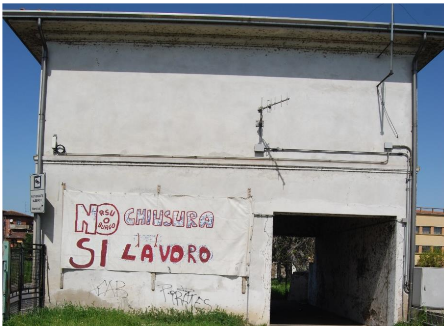
Fronte Sud e con il passaggio della pista ciclopedonale
