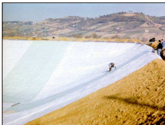
Figura 107 – sistema di impermeabilizzazione degli invasi mediante geomembrana in pvc flessibile
