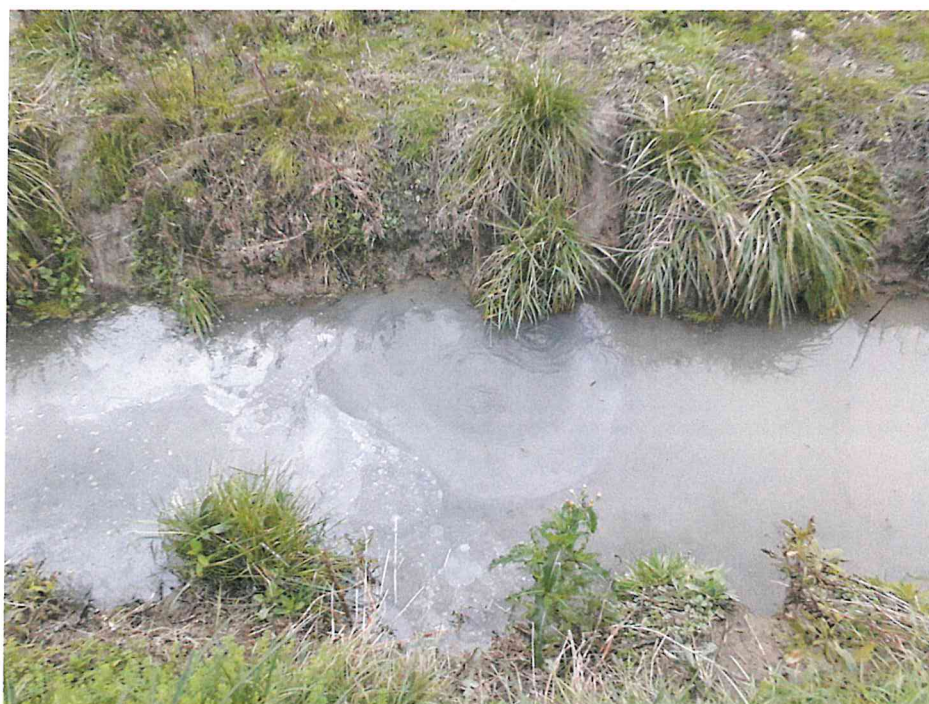
Figura 7 – Fontanazzo ubicato all'interno di un fosso di guardia con asporto materiale terroso - destra idraulica del Po di Maistra – stante 25-26 -comune di Porto Tolle (RO)
