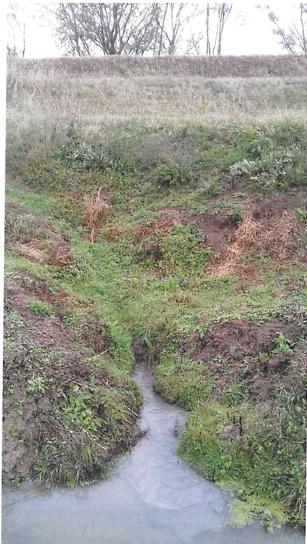
Figura 9 - Incisione del piedibanca arginale a seguito di piping con asporto materiale terroso - destra idraulica del Po di Maistra – stante 25 -comune di Porto Tolle (RO)
