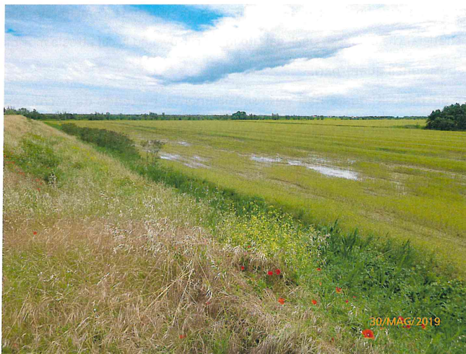
Figura 10 – Filtrazione diffuse a livello del piano campagna - sinistra idraulica del Po di Maistra – stante 651 – 653 - comune di Porto Viro (RO)
