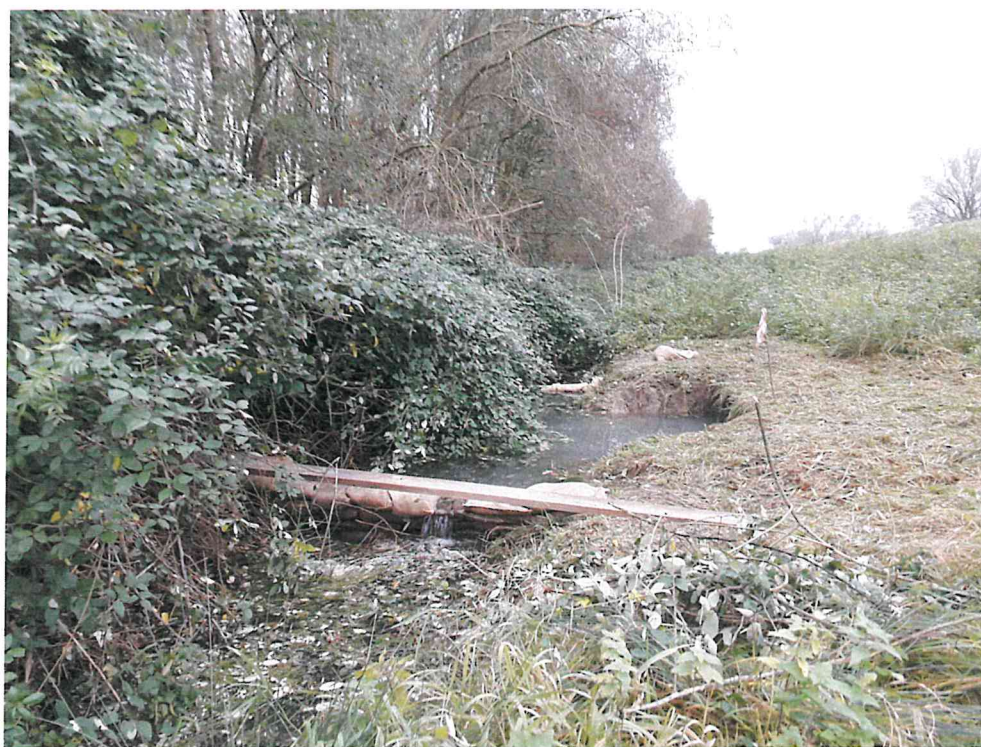
Figura 8 - Incisione del piedibanca arginale a seguito di piping con asporto materiale terroso - destra idraulica del Po di Maistra – stante 14 -comune di Porto Tolle (RO)
