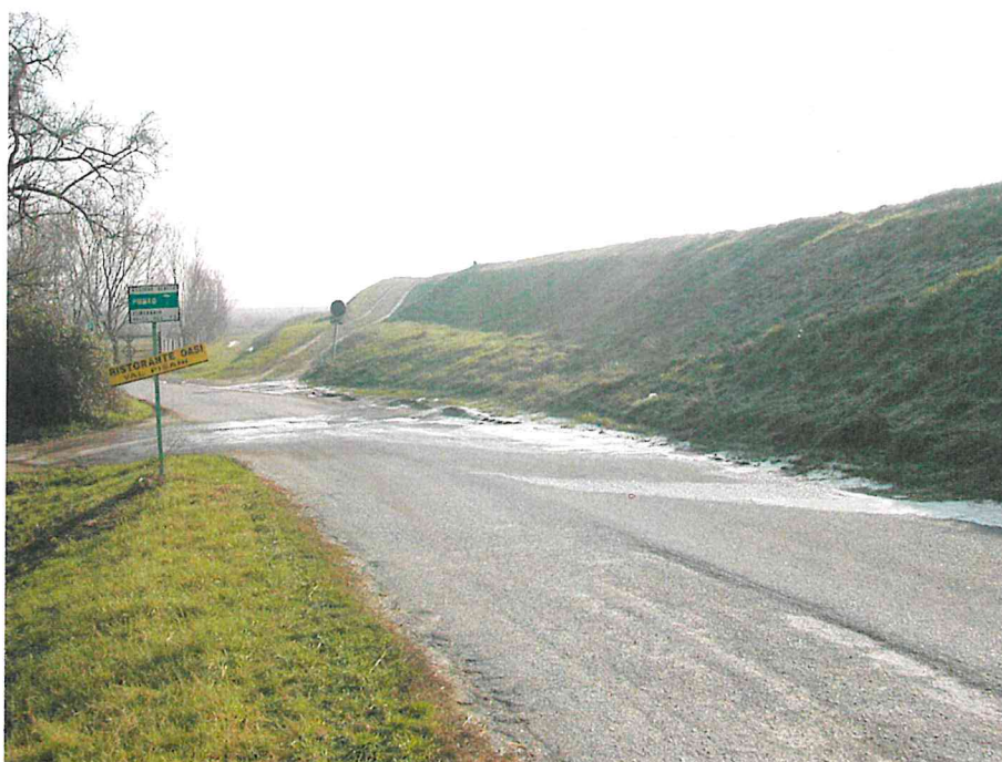
Figura 11 – Filtrazione diffusa attraverso il corpo arginale - destra idraulica del Po di Maistra - loc.tà Barchessa Ravagnan
