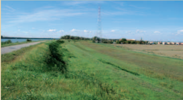
Figura 3. Ripresa dalla sommità arginale dell'arginatura e dell'adiacente campagna - sinistra idraulica del fiume Po di Venezia - stanti 604-608 – in lontananza è visibile l'abitato di Villaregia nel comune di Porto Viro (RO).
