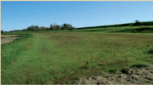
Figura 4. Vista dell'arginatura maestra dalla piazza bassa.
