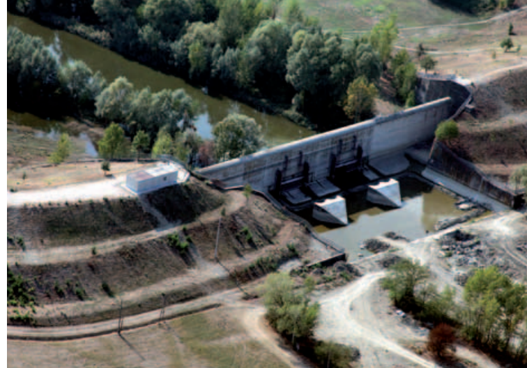
Cassa d'espansione del Crostolo - Manufatto di "chiusura" in cemento armato con dissipatori posti all'uscita delle bocche
