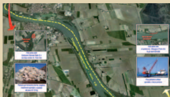
Figura 9. Realizzazione del rivestimento spondale in pietrame naturale a mezzo pontone con fornitura via fiume dei materiali.
