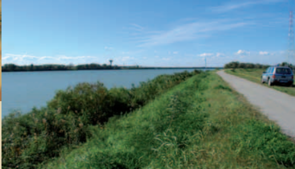
Figura 2. Vista lato fiume dell'argine maestro in sinistra idraulica del fiume Po di Venezia - stanti 604-608 – comune di Porto Viro.
