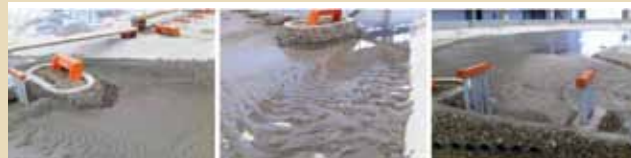
Fig. 21 – Fondo alveo al termine della sperimentazione delle opere di cantiere
